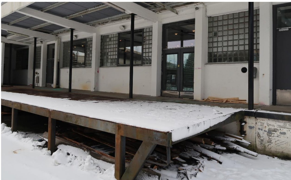
Figur 4: Rampe på utsiden av og over ventilasjonsrom for aggregat 360.02.
