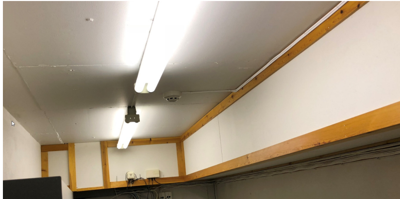
Bilde venstre over - Kantine: Golvmonterte tilluftsventiler rives. Gjennomføringer lukkes. Bilde høyre over - Plan kjeller: Innkassing av tilluftskanal til golvmonterte ventiler rives og kanaler fjernes.
