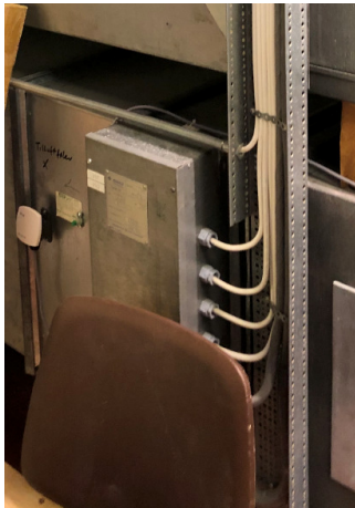
Bilde over - Plan kjeller Vifterom: El. varmebatteri skal rives.
