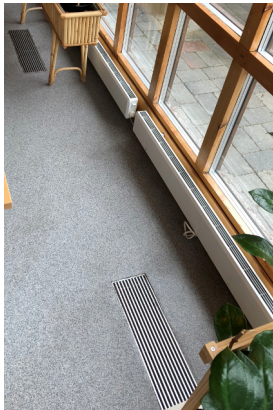
Bilde venstre over - Kantine: Golvmonterte tilluftsventiler rives. Gjennomføringer lukkes. Bilde høyre over - Plan kjeller: Innkassing av tilluftskanal til golvmonterte ventiler rives og kanaler fjernes.
