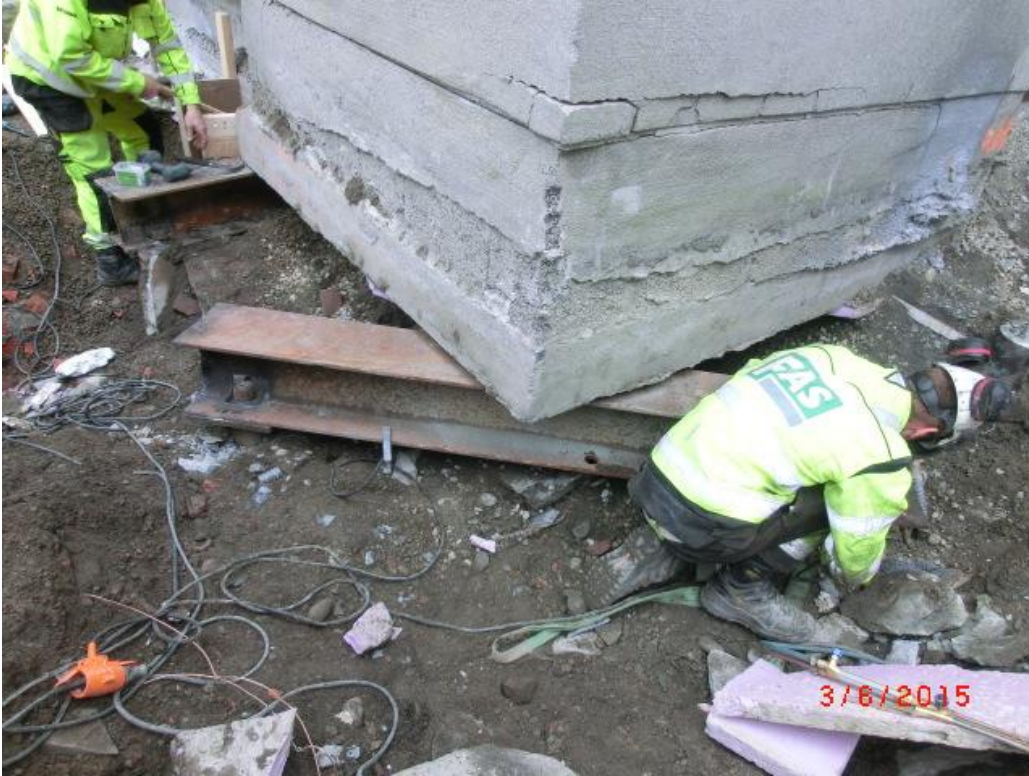
Bilde 3 viser nordøstre hjørne med påstøpt sokkel og understøttende stålbejker, sett fra nord
