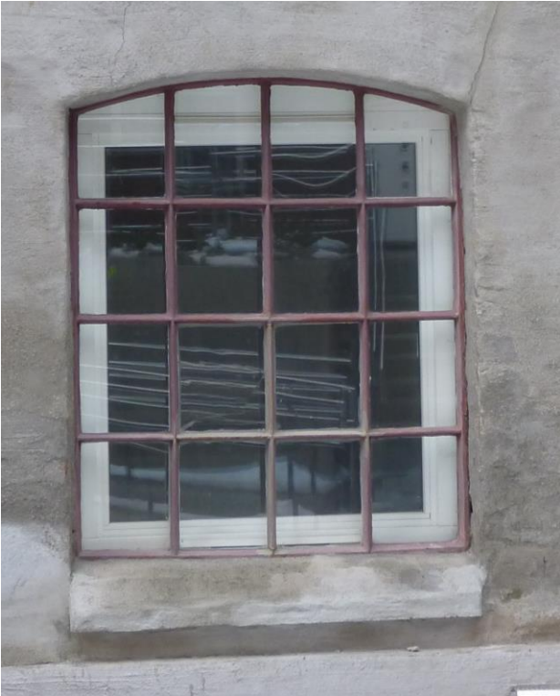
Bilde 7 viser type vindu i 1 etasje
