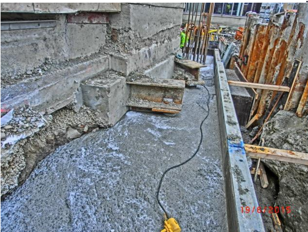
Bilde 4 viser nordøstre hjørne med påstøpt fundament rundt bygget og understøttende stålbejker, sett fra sør
