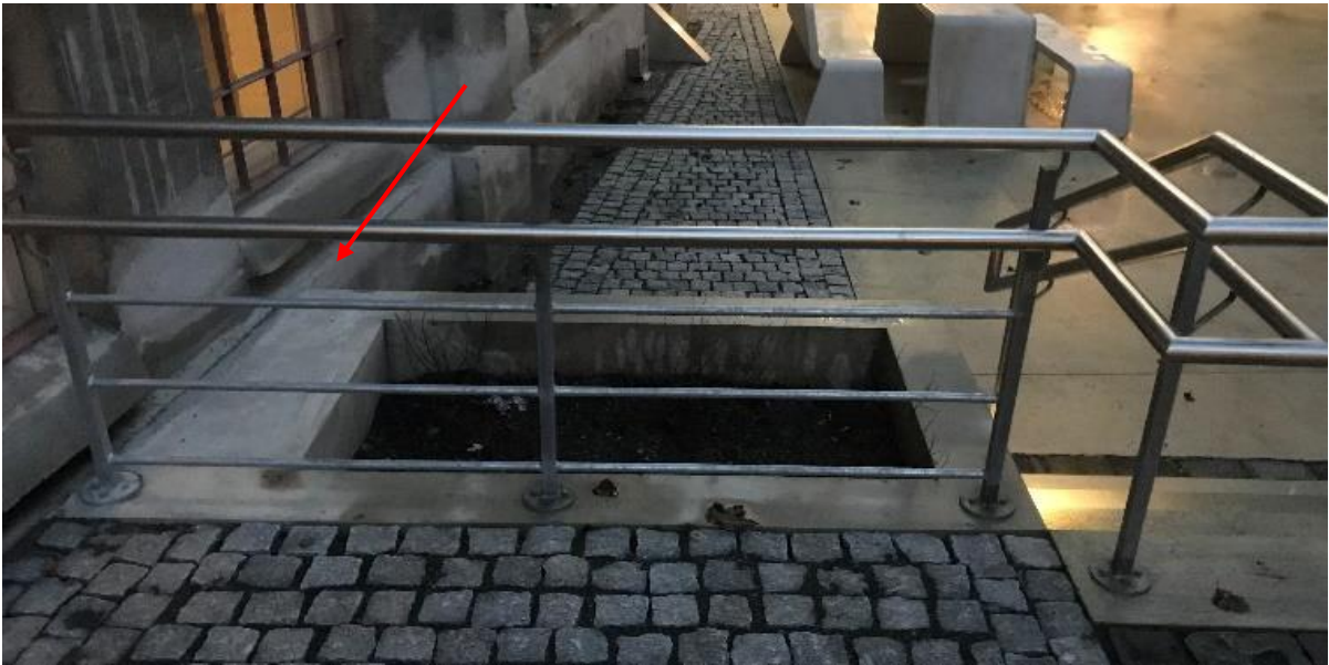
Bilde 1 viser repos på østfasade, sett fra sør
