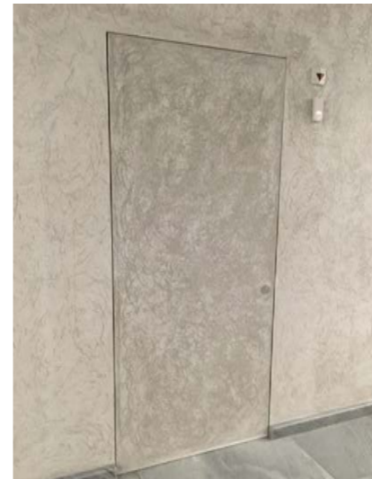
Skjult dør, pusset overflate
