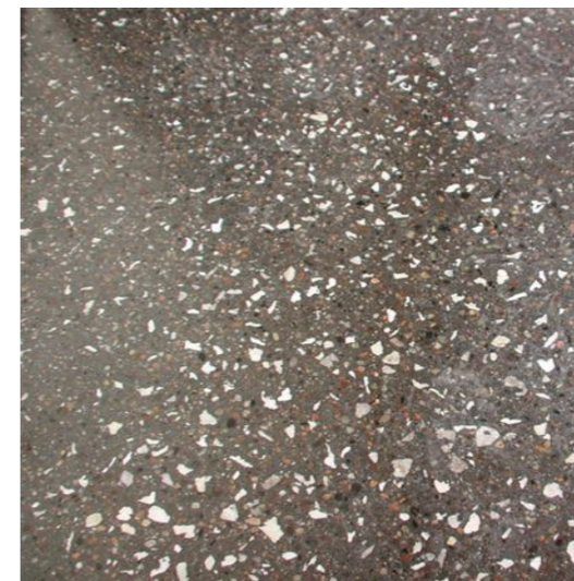
Slipt betong - lyst tilslag, mørk betong
