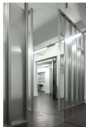
Modulvegger med synlige stendere og galvanisert ståloverflate
