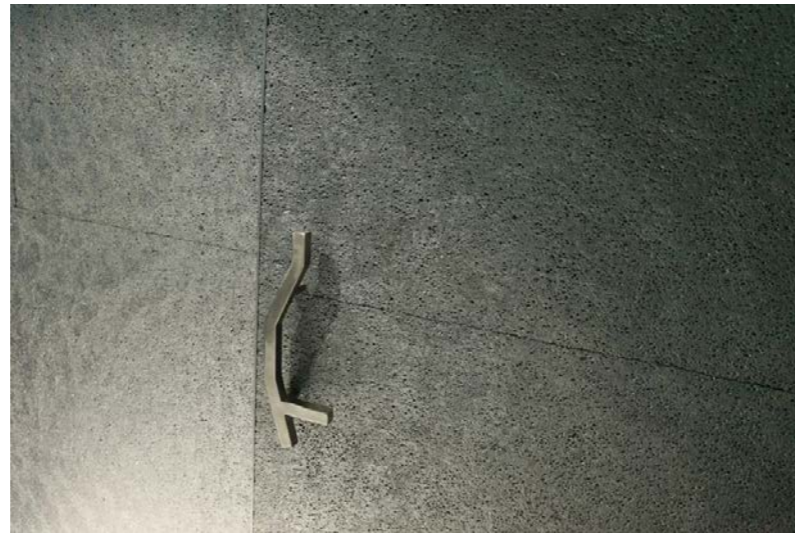
Spesialdør, pivot-dør med aluminiumskumoverflate.
