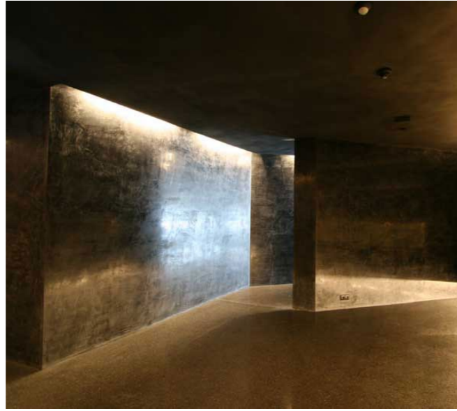
Vegger på toalett behandles med mørk stucco lustro.
