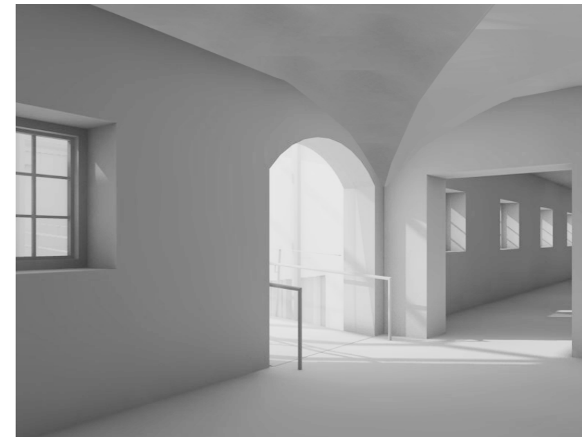
Ny situasjon etasje 0. Sett fra innsiden av Villa Grande.
