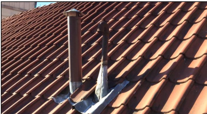
Figur 30: Blybeslag på taket.
