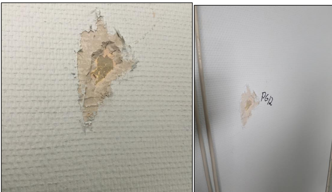
Figur 37: Prøve 12 av pusslag på betongvegg i 3. etasje.
