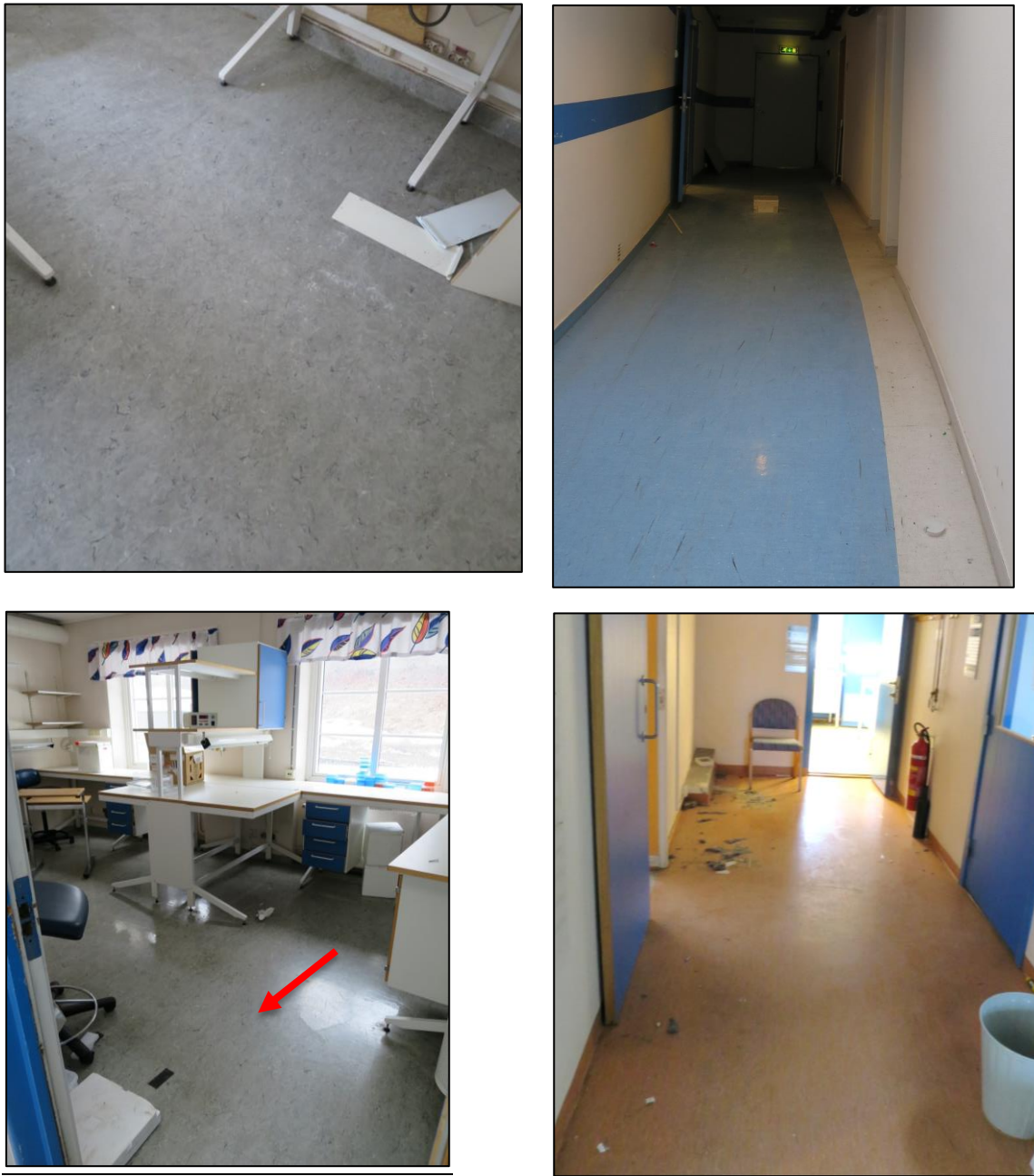
Figur 25: Eksempler på vinylbelegg i Bygg G.
