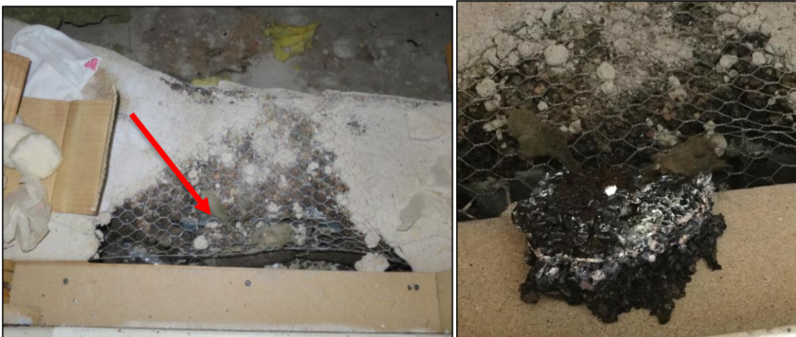
Figur 28: Oljeinnholdig korkisolasjon kan leveres som ordinært avfall dersom mottak akseptere å ta imot det.
