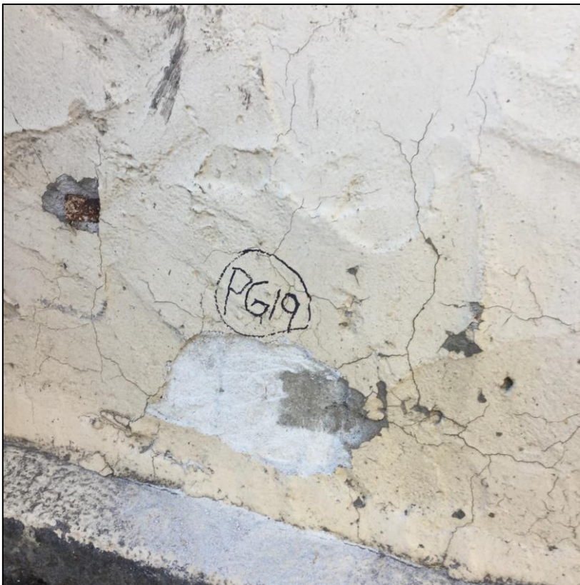
Figur 44 Prøve 19 av maling og puss på utvendig fasadevegg.
