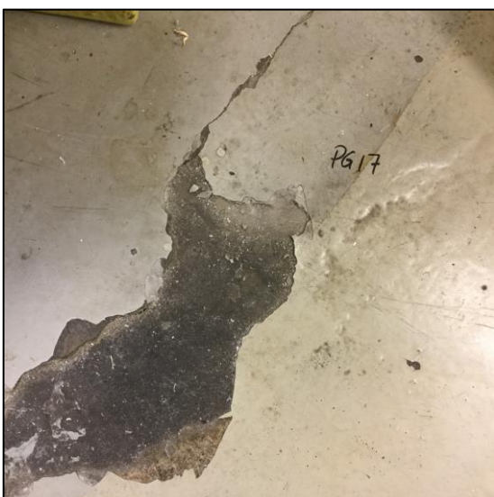
Figur 43: I 1. etasje/kjeller ble det tatt en prøve av epoxy-maling (prøve 17)
