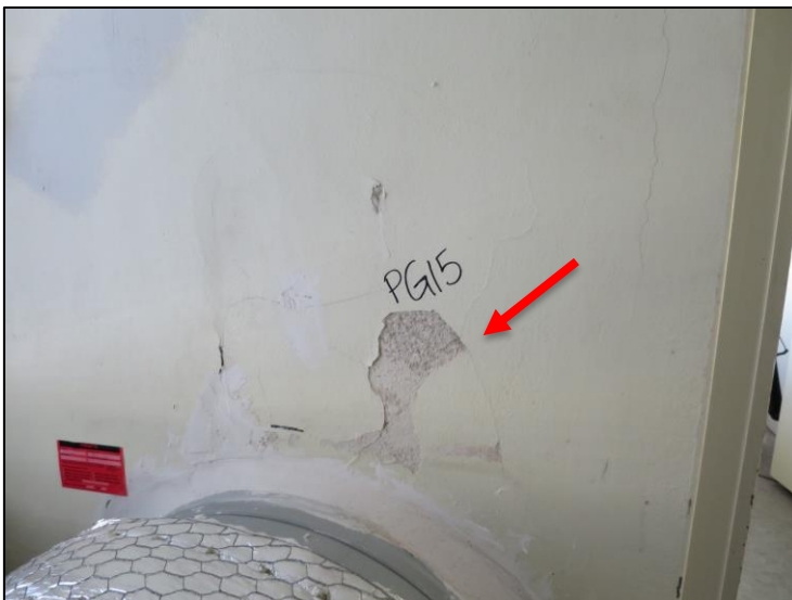
Figur 39: Prøve 15 av maling på betongvegg i 4. etasje.
