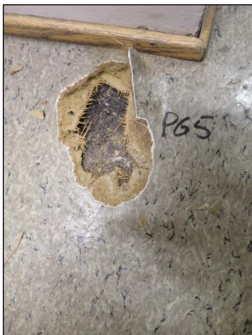
Figur 24: Linoleumsbelegg er ordinært avfall.
