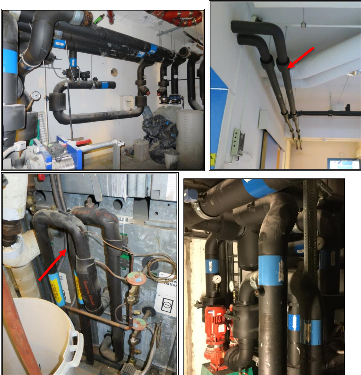
Figur 26: Eksempler på bruk av cellegummi-isolasjon.
