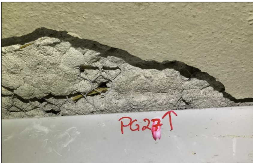
Figur 13: Rabitzpuss på himling i rom ved siden av ventilasjonsrom i 4. etasje inneholder ikke asbest.
