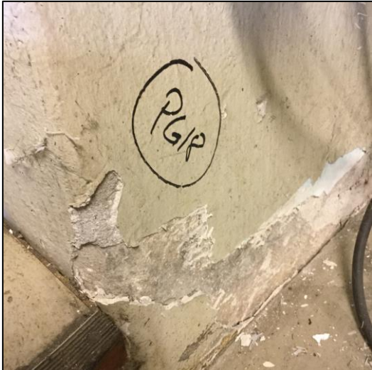
Figur 41 Prøve 18 av maling på verkstedet i 1. etasje.
