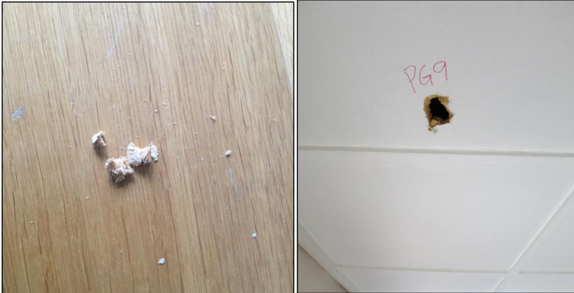
Figur 12: Himlingsplate i 3. etasje inneholder ikke asbest.
