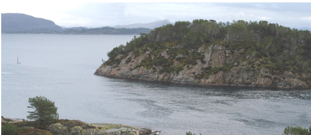
Krossneset sett fra brua, overgangsmasten vil bli stående ytterst på neset
