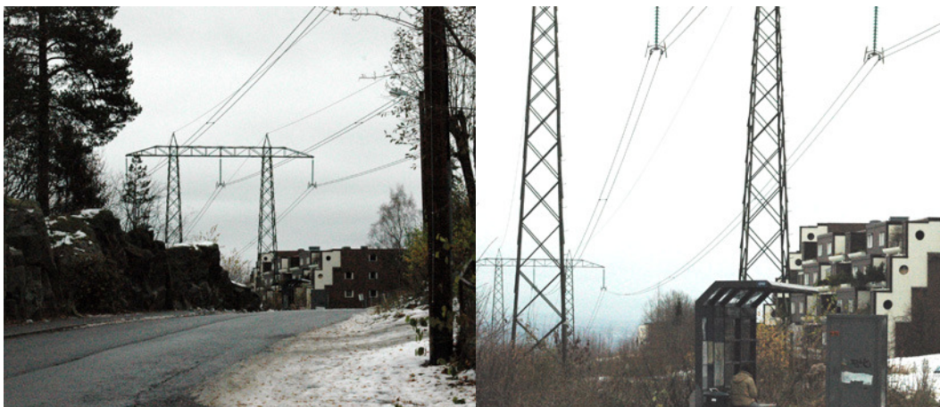
300 kV bæremast gjennom tett bebyggelse
