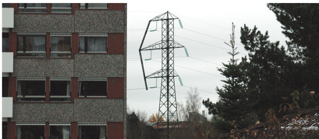
Vinkelmast ved Hovseter
