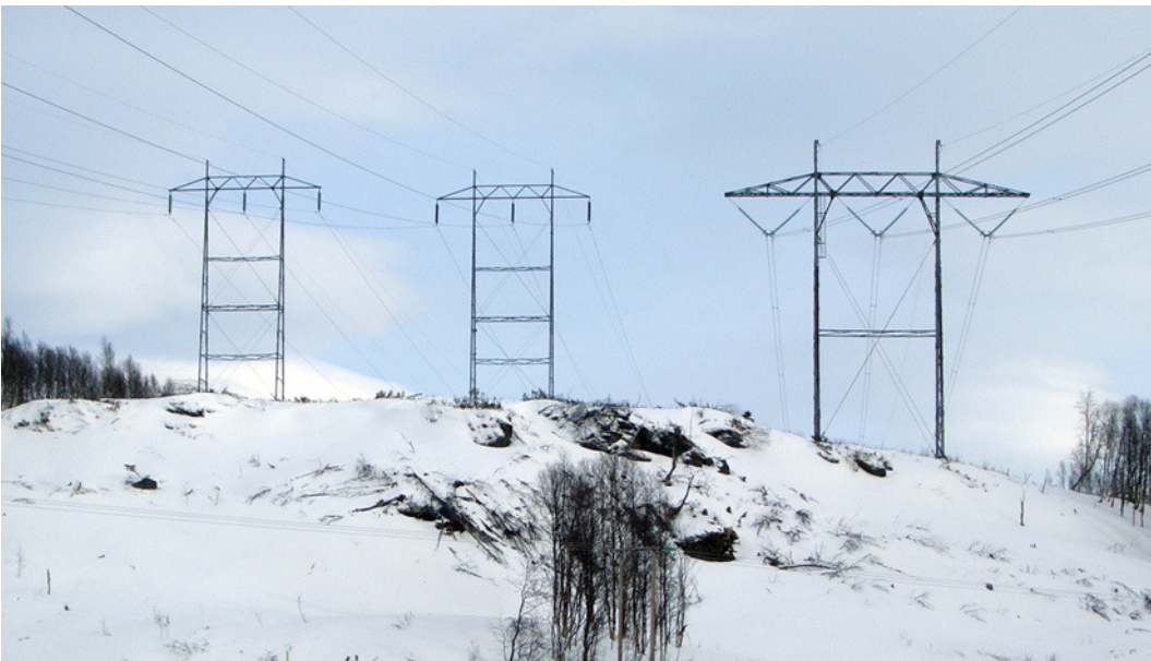
To nesten like mastetyper i parallellføring av to 132 og én 420 kV ledning gir en dominerende virkning da ingen ledning er overordnet de andre, NVE
