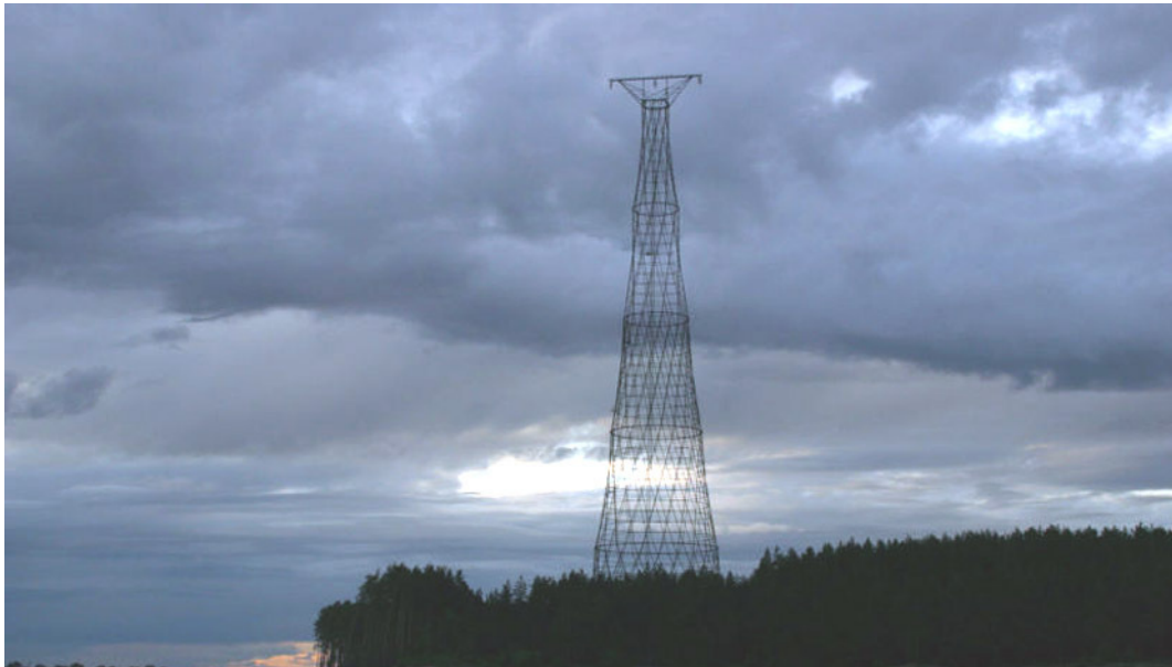
Det homogene fagverket får en ellers enorm mast til å virke lett, Oka Tower, Russland
