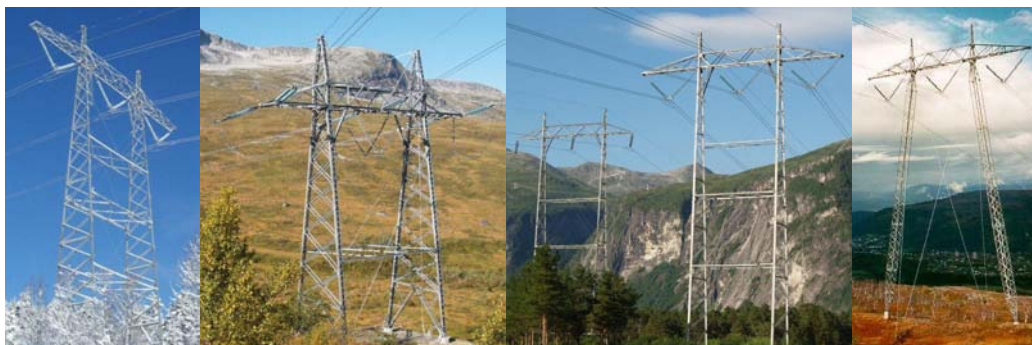
Fra venstre: Standard portalmast, forankringsmast, bæremaster med hhv I og V-kjede samt utvendig bardunert mast, Statnett
