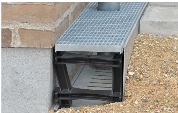
Prinsippfoto: Sokkelrenne mot fasade
