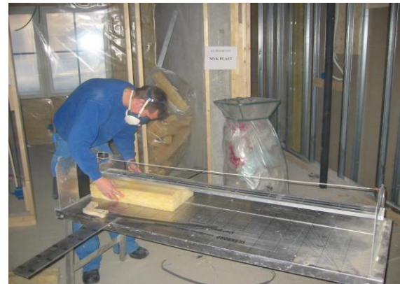
Bildet viser en ryddig arbeidsplass hvor avfallssekker for avkapp av isolasjon og plastfolie er plassert rett ved der avfallet oppstår, noe som gjør at det er lett å sortere avfallet. Foto: Sverre Valde.
