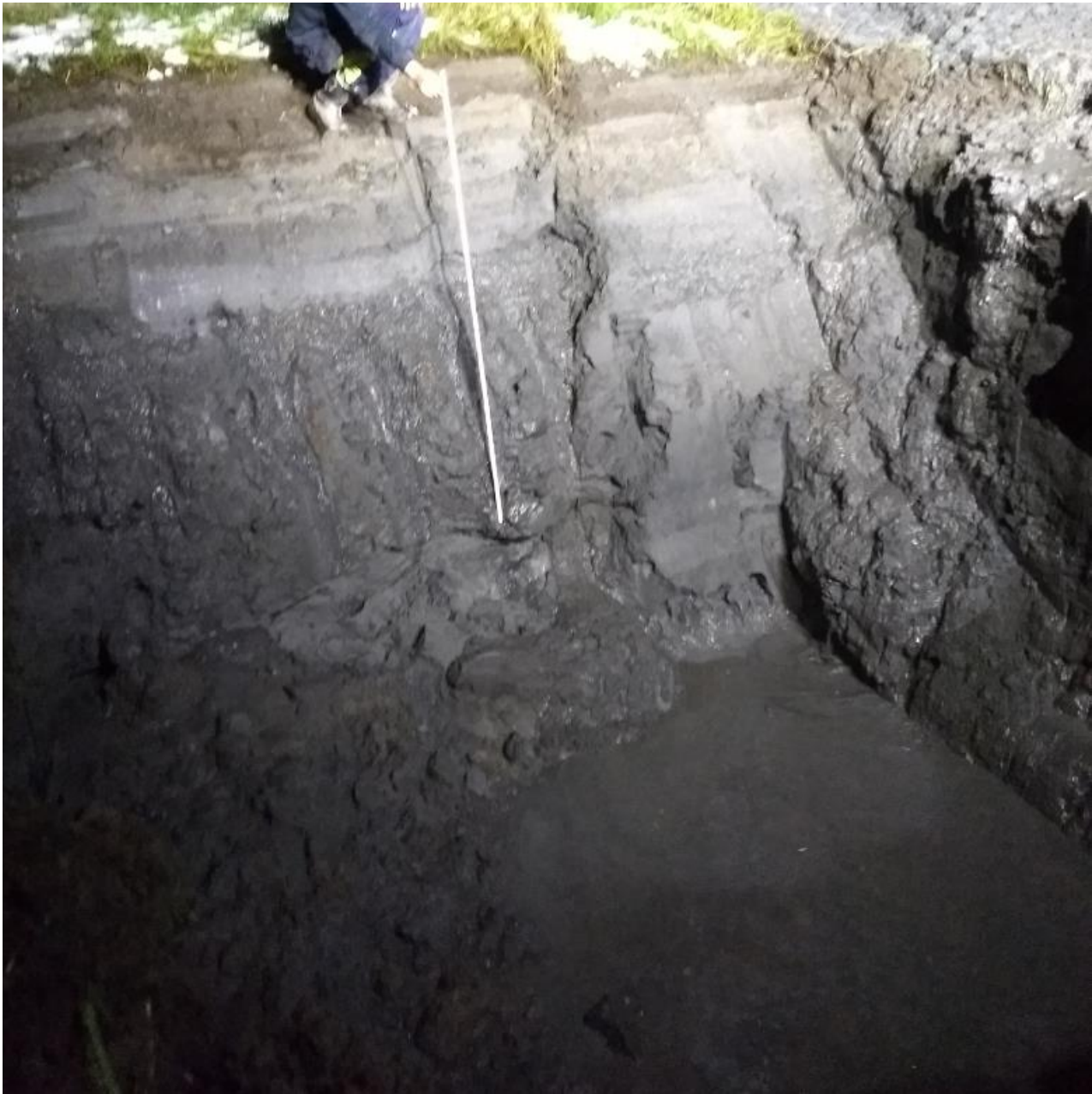
Figur 3. Utgraving til ca. 3 meter dybde.
