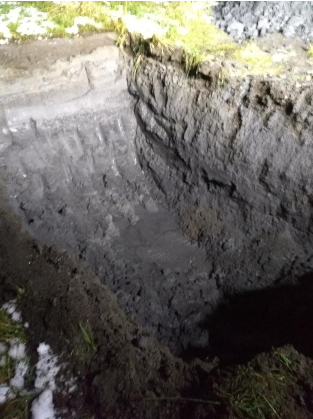
Figur 2. Ca. 2 meter utgraving. Betydelig tilsig av vann
