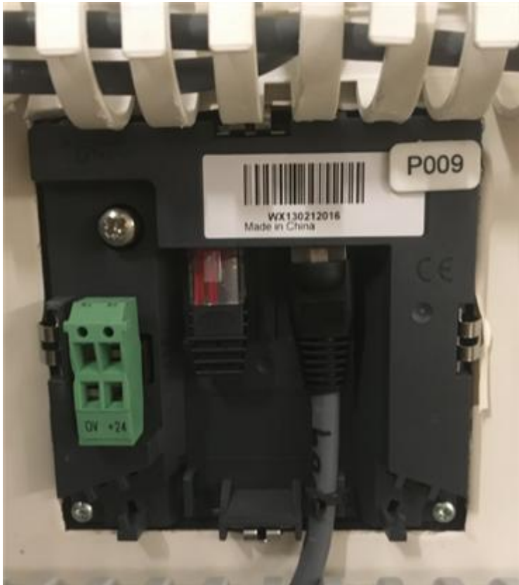
Baksiden av multi-instrument i tavlefront - Eksempel type: FDM121 fra Schneider
