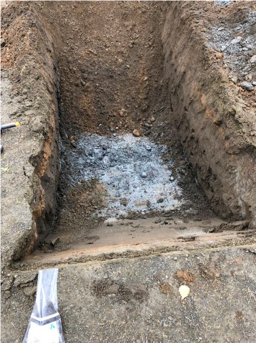
Figur 2-4 Bildet viser prøvesjakt 7 (U-P7). Sjakten er 1 m dyp. Massene i sjakten er typisk for området for nytt utbygg av administrasjonsbygg, og består av jord og små stein/grus.
