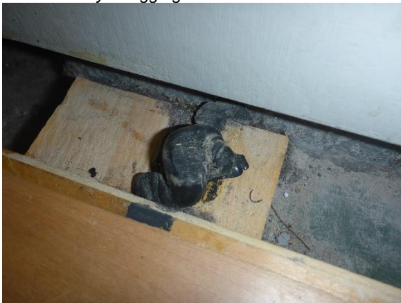
Bilde 19: Svart (støtdempende?) masse under parkettgulvet
