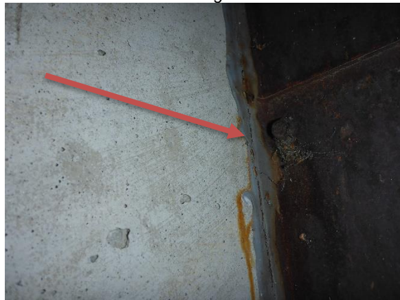
Bilde 20: Myk fuge utvendig langs Cortenplater
