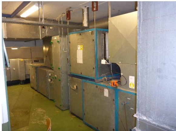
Bilde 31: Ventilasjonsaggregat
