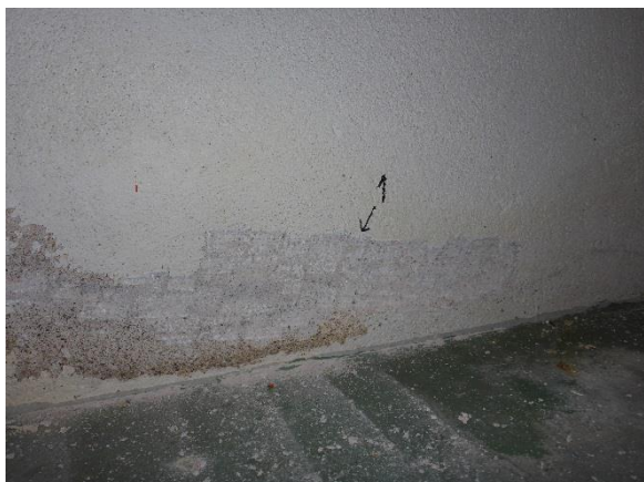
Bilde 5: Murpuss med maling
