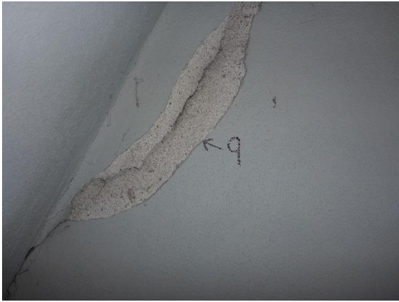
Bilde 11: Murpuss med maling
