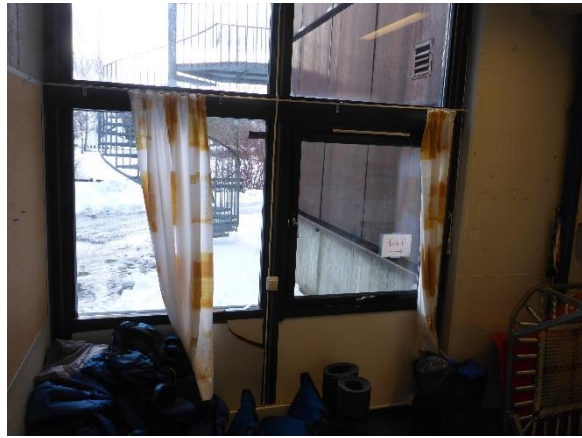
Bilde 18: To av fire felt isolérglass er fra 1990-2005
