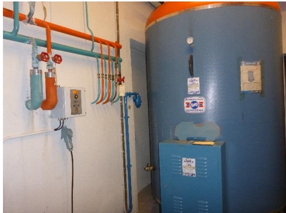
Bilde 29: Varmtvannstank
