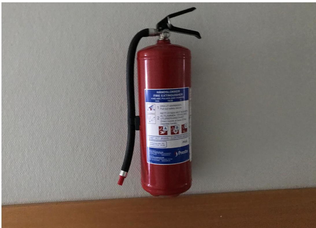
Bilde 11 – Bilde av brannslukningsapparat. Disse må leveres som farlig avfall til godkjent mottak. Mengder i tabell, punkt 4.4.
