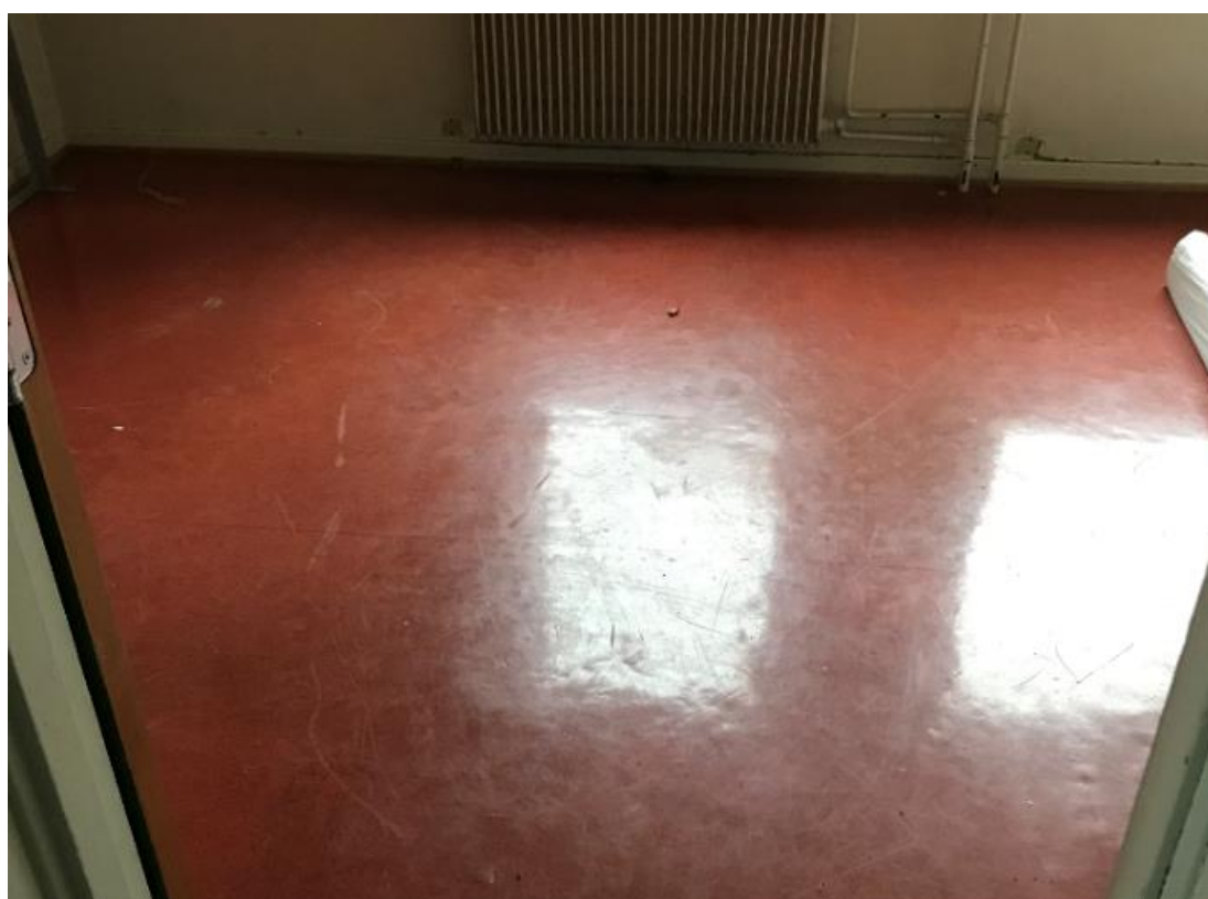
Bilde 14 – Bilde viser eksempel på gulvbelegg som ikke ble prøvetatt. Da alle prøvetatte belegg er farlig avfall med ftalater må også alle ikke-prøvetatte gulvbelegg leveres som farlig avfall til godkjent mottak. Mengder i tabell, punkt 4.4.
