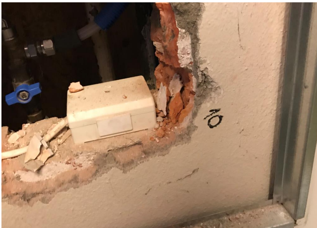
Bilde 8 – Bilde fra prøve 10. Puss/maling på teglvegg ble analysert for PCB og tungmetaller. Prøven viser en forekomst av tungmetaller over normverdien for forurensete masser, mens forekomsten av PCB er under normverdien for forurensete masser. Massene må leveres som lett forurenset til godkjent mottak. Mengder i tabell, punkt 4.4.
