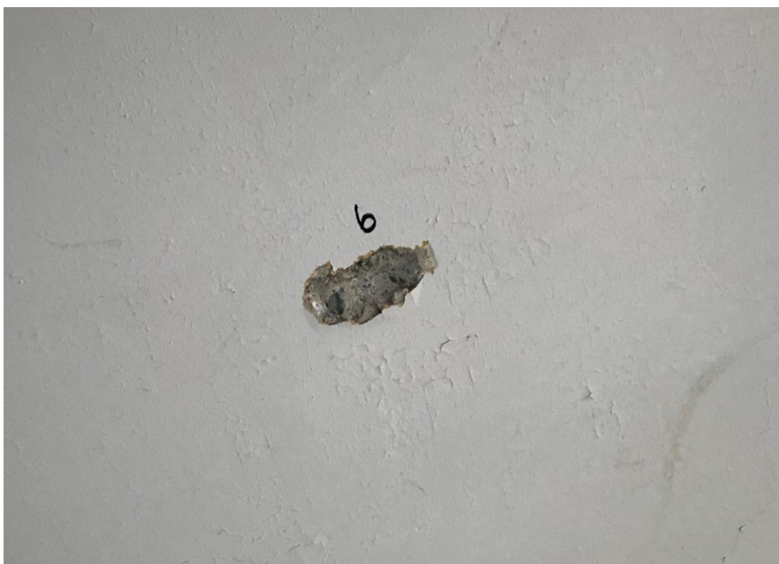
Bilde 4 – Bilde fra prøve 6. Hvitmalt betong fra underside av dekke over 1.etg ble analysert for PCB og tungmetaller. Prøven viser en forekomst av tungmetaller over normverdien for forurensete masser, mens forekomsten av PCB er under normverdien for forurensete masser. Massene må leveres som lett forurenset til godkjent mottak. Mengder i tabell, punkt 4.4.
