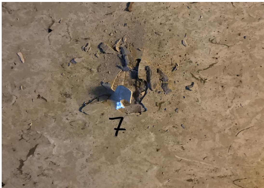
Bilde 5 – Bilde fra prøve 7. Gulvbelegg i kjeller ble analysert for ftalater. Prøven viser en forekomst av ftalater over grensen for farlig avfall. Gulvbelegget må leveres som farlig avfall til godkjent mottak. Mengder i tabell, punkt 4.4.
