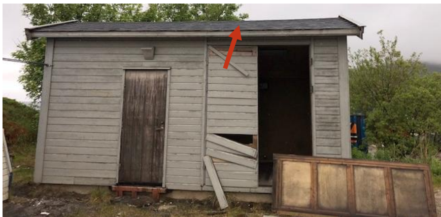
Figur 2 Brakke som står på eiendommen. Brakka er oppført i tre, med betongfundament og teknet med sort takpapp. Betongen under brakka og takpappen er ikke prøvetatt.
