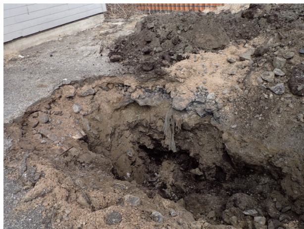
Bilde 6: Sjakt M9.
