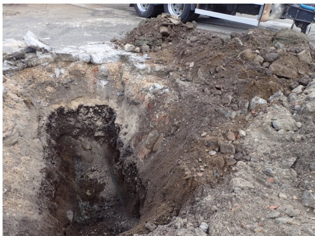
Bilde 5: Sjakt M8.
