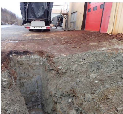
Bilde 3: Sjakt M3.
