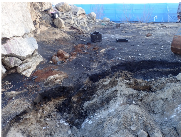
Bilde 1: Sjakt M1.
