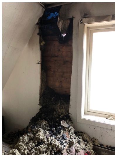
Viser hvor det er skjert hull i vegg for å kunne slukke brannen.
