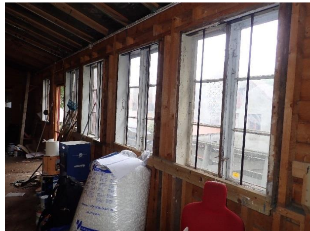
Bilde 4: Hvit karmmaling. Påvist tungmetaller
