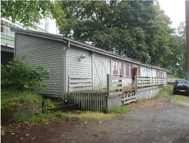
Bilde 1: Grå maling på yttervegger, Lagerbod
