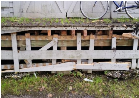
Bilde 8: Utvendig terrasse ved lagerbod
