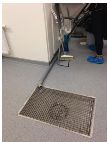
Sluk montert midt på gulvet for enklere tilgang ved tømning av gulvvaskemaskiner.
