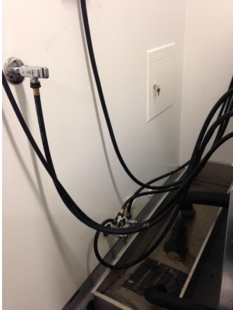
Lokasse montert bak vaskemaskin. Krever ekstra plass for enklere rengjøring.
