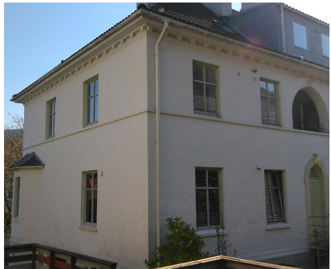
Figur 4: Nordvest-fasade av bygningsmasse. Foto er tatt mot øst.
