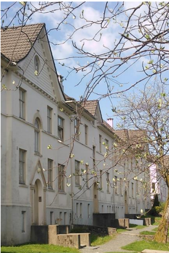
Figur 3: Nordøstre fasade av bygningsmasse. Foto er tatt mot vest.
