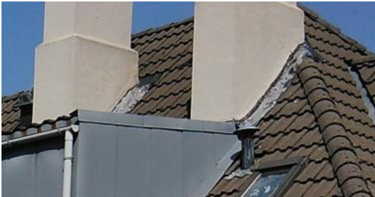
Figur 13: Blybeslag mellom piper og tak.
