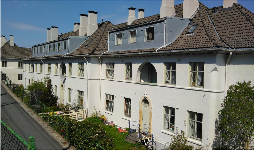
Figur 2: Sørvest-fasade av bygningsmassen i Lotheveien 2–6. Foto er tatt mot nord.
