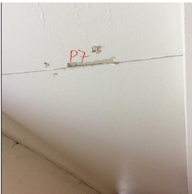
Figur 6: Prøvetatt plate (P7) i himling i vaskebod i kjeller. Det ble ikke påvist asbest i himlingsplaten.
