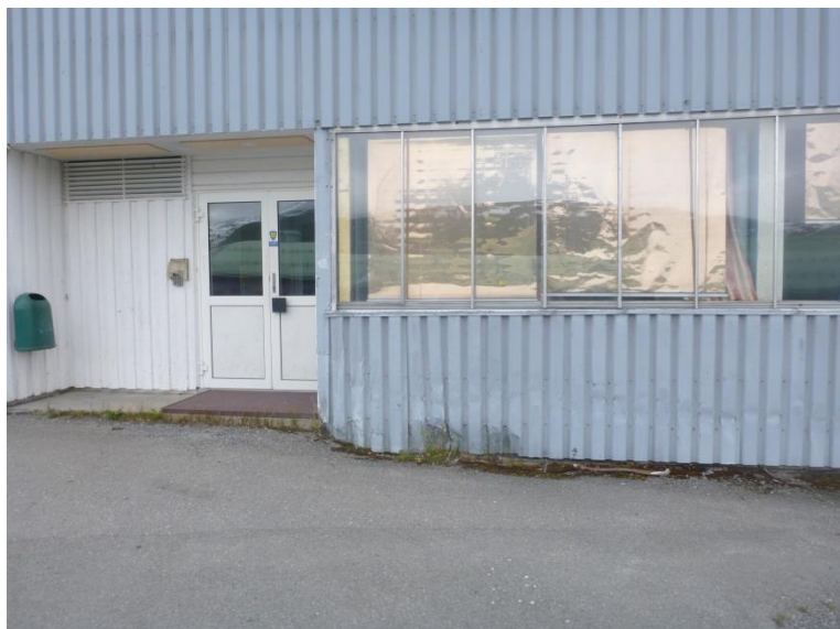
Vinduer generelt i bygget.
