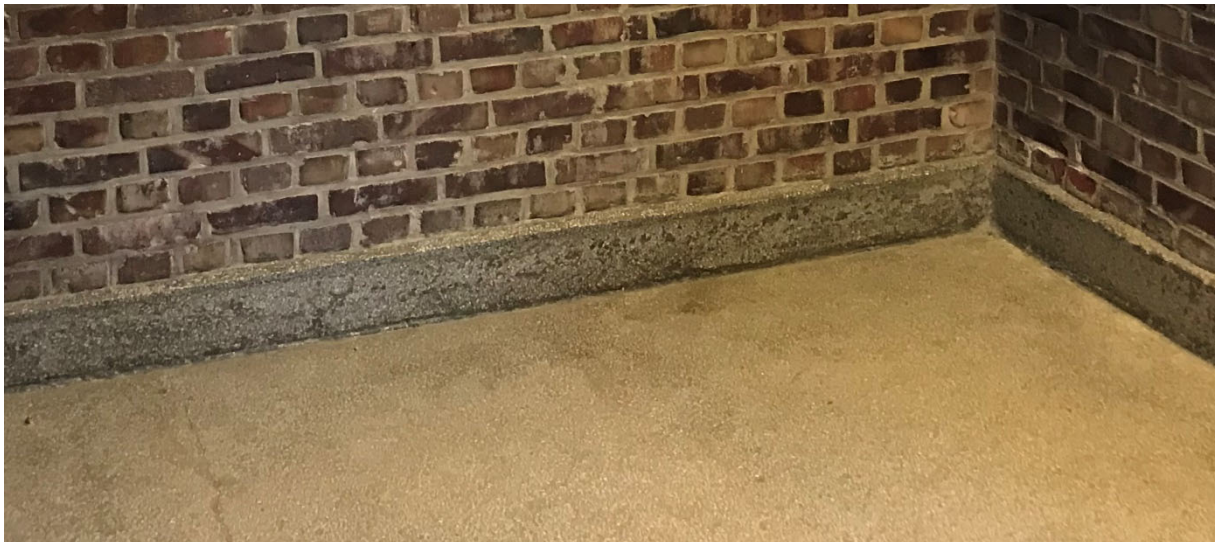
Foto over: Eksisterende terrassogulv i søndre trappehus.
