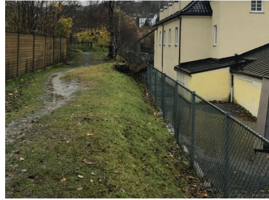
Mur sett fra oppsiden.
