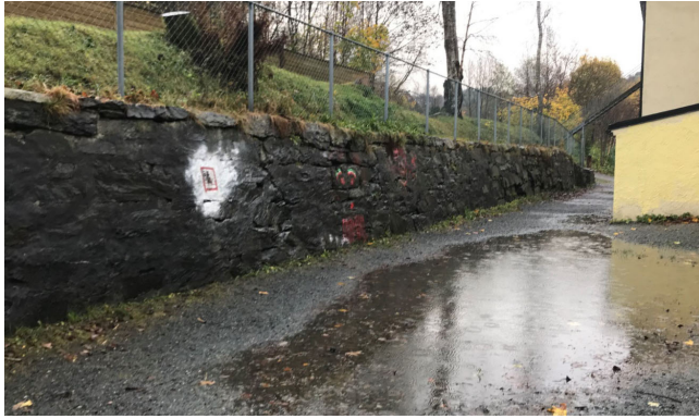
Mur sett fra nedsiden.
