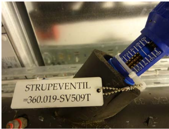
Eksempel på merking av ventil. SV er komponentkode for strupeventil.
