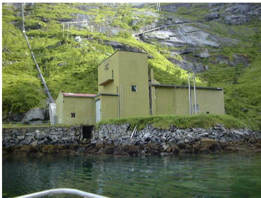
Forsfjord kraftanlegg før byggrehabilitering
