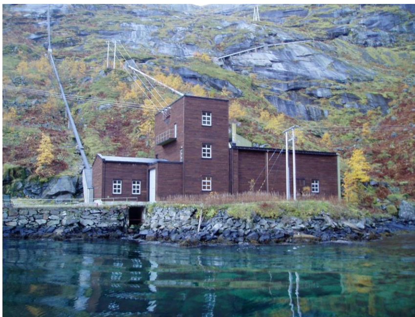
Forsfjord kraftanlegg etter byggerehabilitering
