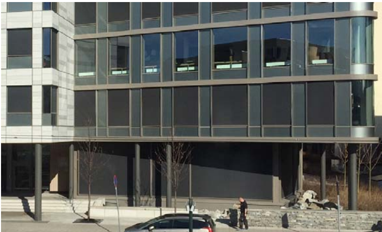
Figur 3 Eksempel på fasade med screen trukket ned i 1. og 2. etg. Inntrykket er lukket og flatt.
