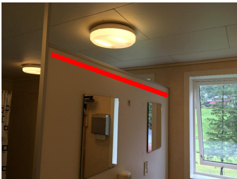
Bilde 7: Plassering av kanal på skillevegg, dusjrom.
