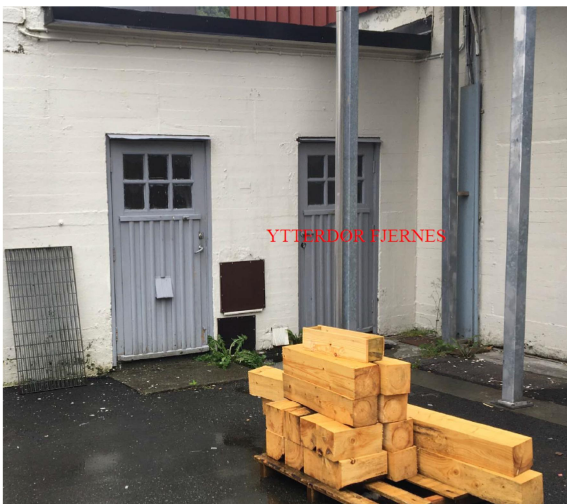
Bilde 1: Ytterdør ved fremtidig tekniskrom fjernes.
