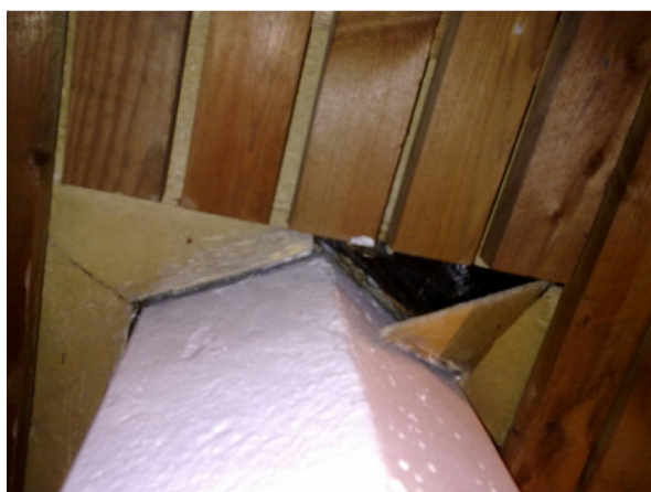
Bilde 5: Topp søyle i hall. Betongsøyle, spilehimling, plate og dampsperre (svart).
