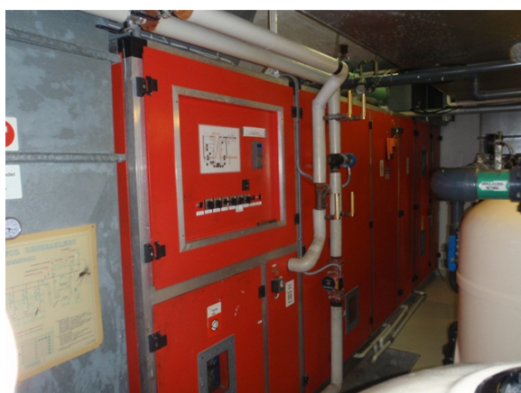
Bilde 15: Aggregat fra 1994 for svømmehall.
