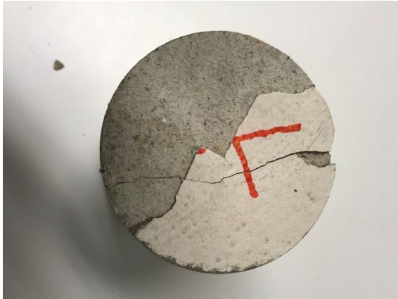
Kjerneprøve boret gjennom riss. Kjerne sett fra utsiden.
