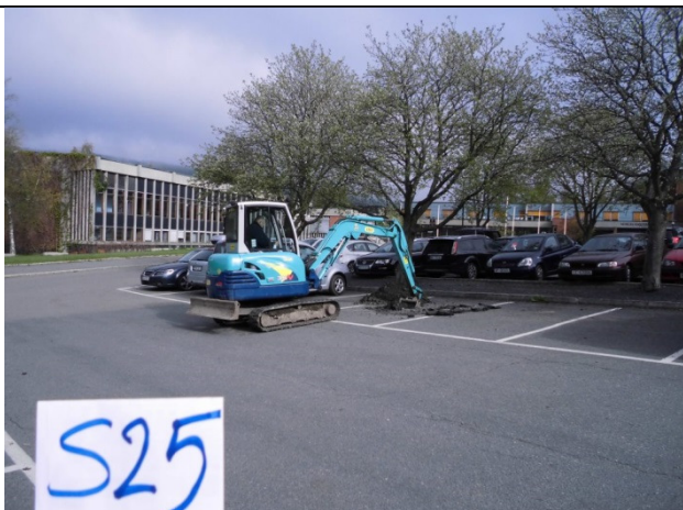
Foto 7. Graving av sjakt i punkt S25.
