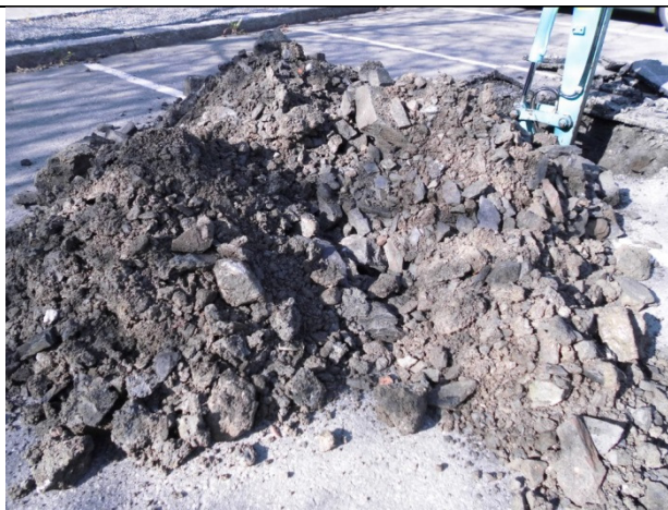
Foto 10. Oppgravde masser fra punkt S26.
