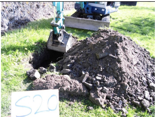
Foto 5. Oppgravde masser fra punkt S20.
