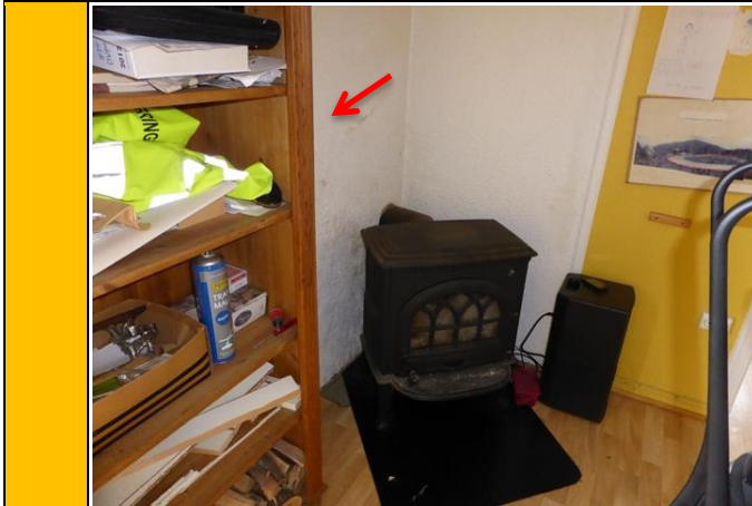
Bildet viser pipe i stue i 2. etasje.
