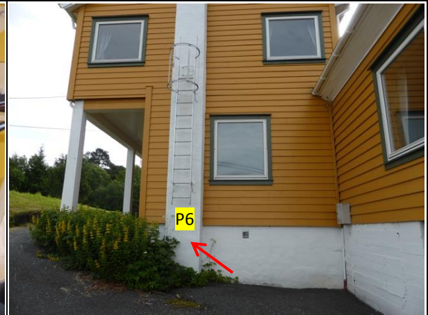
Bildet viser maling og puss på skorstein utvendig med prøveplassering P6.
