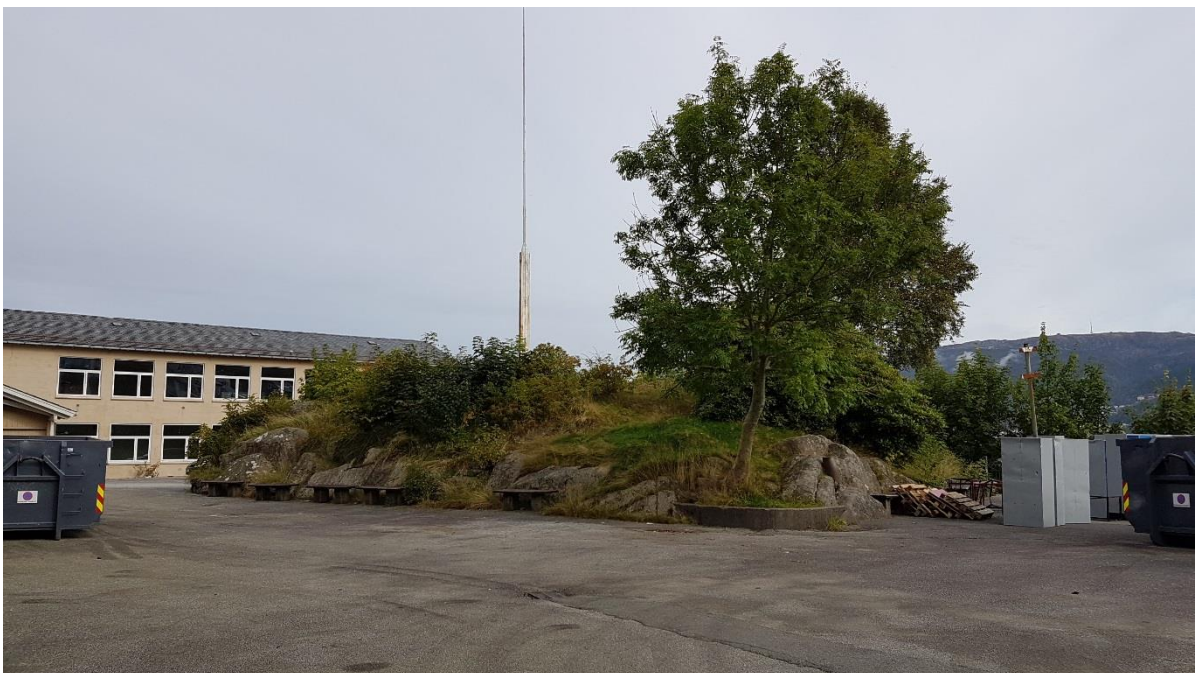
Figur 6. En bergknaus med grøntområde midt på skoleplassen til Håstein skole. Treet som ses ca. midt i bildet er ask. Bildet er tatt mot nord.
