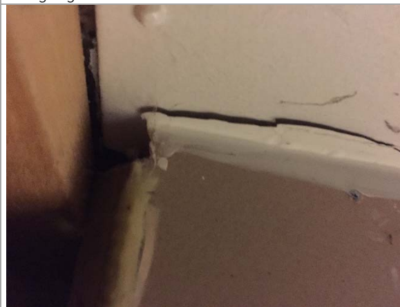
Bilde 5 Eternittplater vegg i rom for ventilasjonsanlegg
