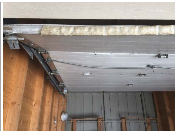
Bilde 13 Garasjeport mot tilbygg
