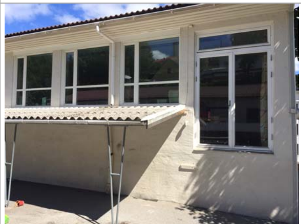
Bilde 6 Eternitt takplater leskur A hovedbygg
