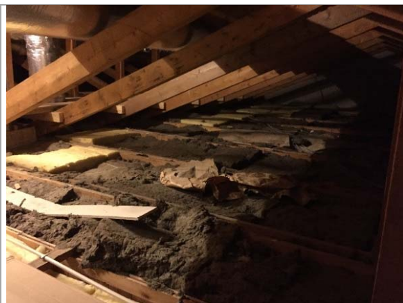
Bilde 8 Isolasjon mellom loft og 2. etg, hovedbygg
