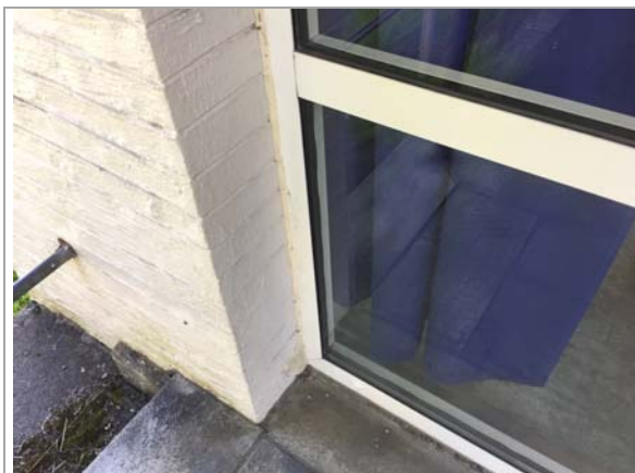
Bilde 11 Fuge hovedbygg
