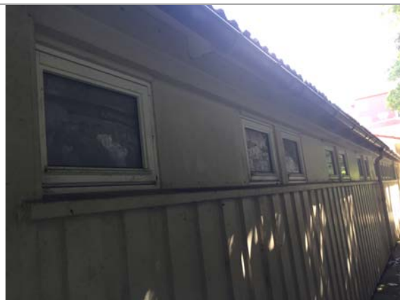
Bilde 2 Eternittplater på fasade mellom vindu SFO bygg
