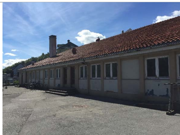
Bilde 2 Asbest veggplater på nordvendt fasade gymbygg
