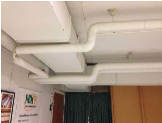
Bilde 3. U. etg. Tilfluktsrom. Skjøt på ventilasjonsanlegg, P1.
