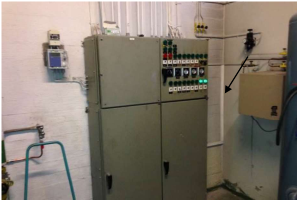
Bilde 15. Eksempel på kabelskinner, fyrrom.
