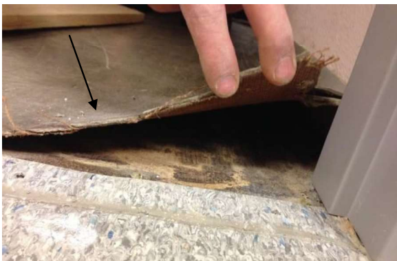
Bilde 18. Linoleumsbelegg. Overgang til korridor.
