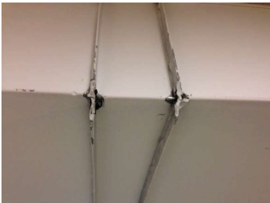
Bilde 2. U. etg. Tilfluktsrom. Skjøt på ventilasjonsanlegg, P1.
