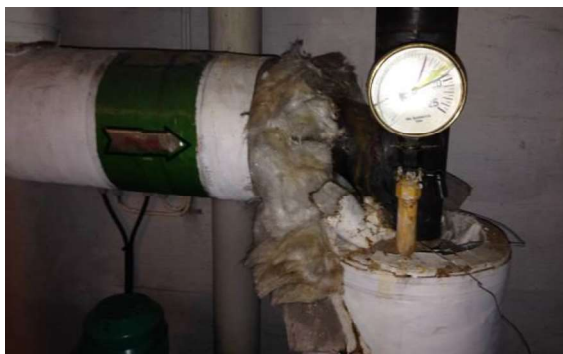
Bilde 9. U.etg. Fyrrom. Ende på rørisolasjon, P8.
