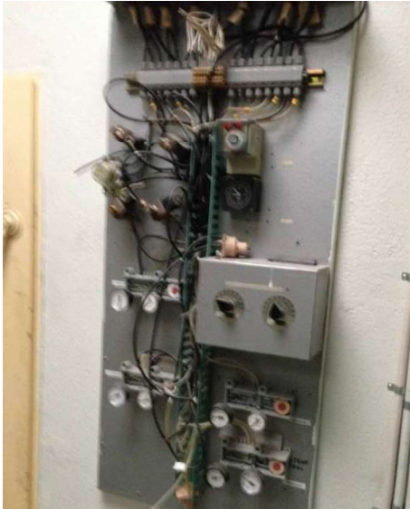
Bilde 22. Eksempel på EE-avfall. Her i ventilasjonsrom.
