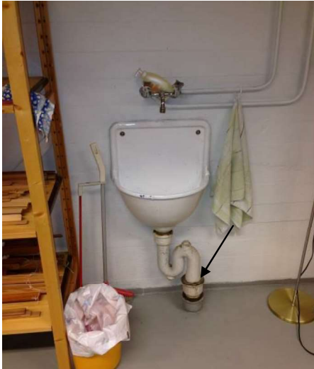
Bilde 19. Soilrør med bly. Her i tilfluktsrom.
