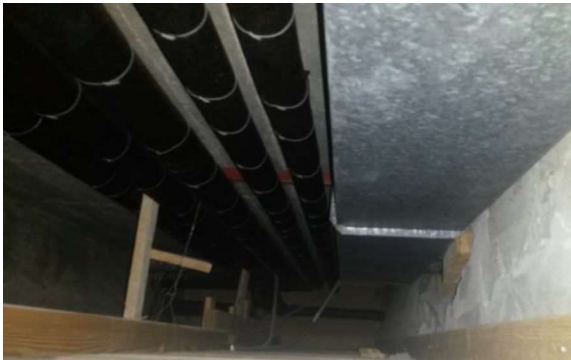
Bilde 13. U.etg. 040 korridor utenfor gymsal. Rørørisolasjon i himling, P14.
