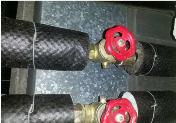
Bilde 12. U.etg. 040 korridor utenfor gymsal. Rørørisolasjon i himling, P13.
