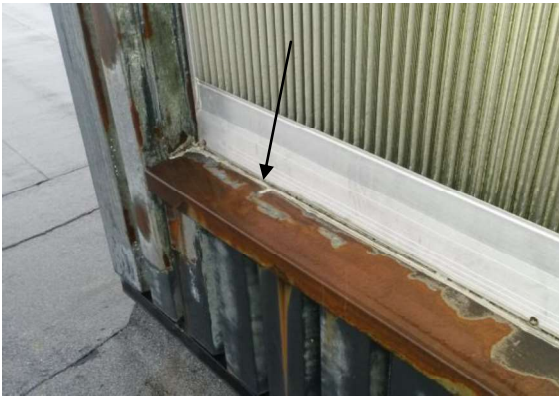
Bilde 26. Fugemasse. Utvendig, teknisk rom på tak.
