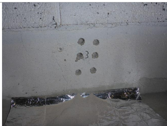
Bilde 3: Betong, vegg
