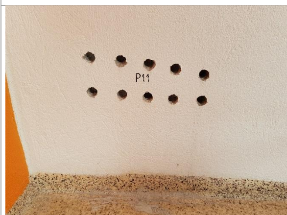
Bilde 6: Betong, vegg
