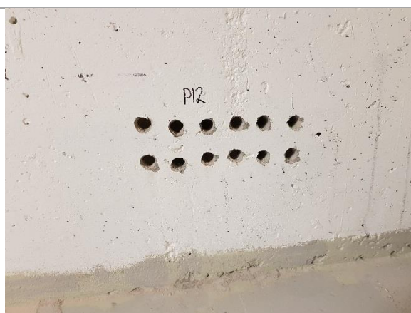
Bilde 7: Betong, vegg
