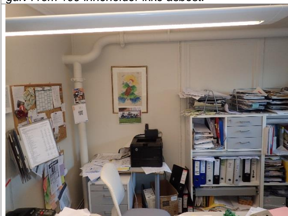
Bilde 3: Veggplater i skillevegger mellom kontor i 2. etasje inneholder ikke asbest.
