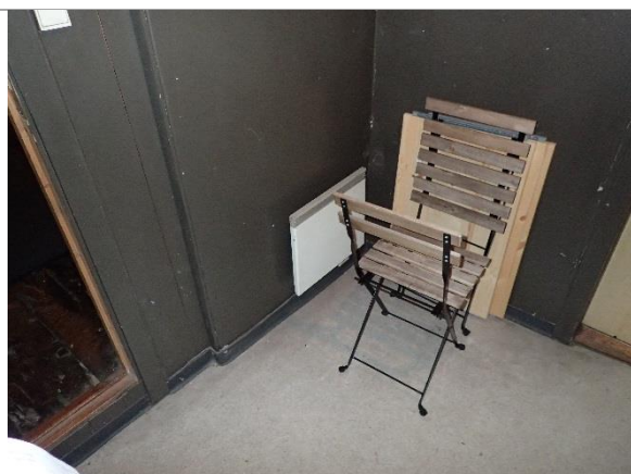
Bilde 2: Veggplater bak metallplater i hjørne i rom 108 er asbestholdige.
