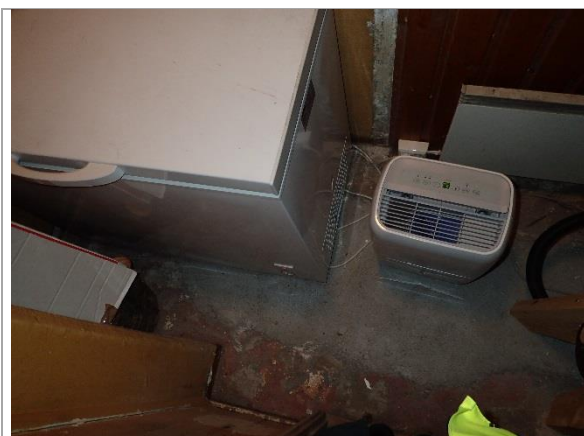
Bilde 1: Murpuss på vegg og avretningsmasse på gulv i rom 109 inneholder ikke asbest.
