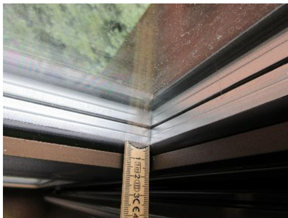
Bilde 2 Tre-lags luftfylt isolerglass med avstandslister og karmen av aluminium.
