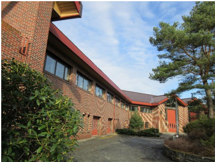
Bilde 1 Østvendt fasade Sandslihaugen 30
