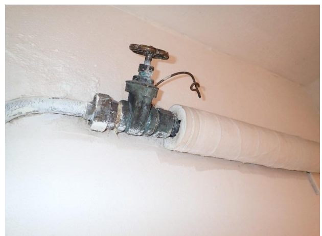
Bilde 5: Endeavslutning på korkisolert rør i underetasjen ble prøvetatt. Ikke asbest.
