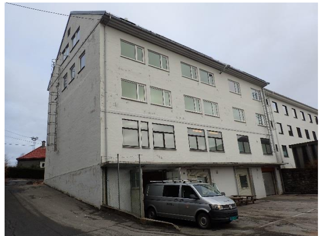
Bilde 10: Fasademalingen inneholder mye sinkoksid fra 1. etasje og oppover.
