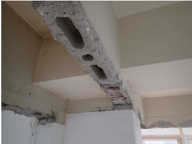
Bilde 7: Eksempel på pusset murvegg som skal rives. Malte overflater på begge sider.
