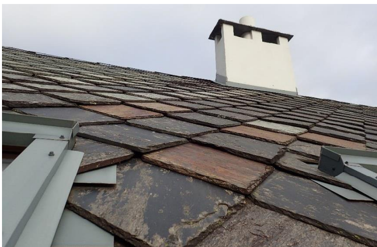
Bilde 2 – Tak med ruteskifer (Otta), skorsteiner og takvinduer.
