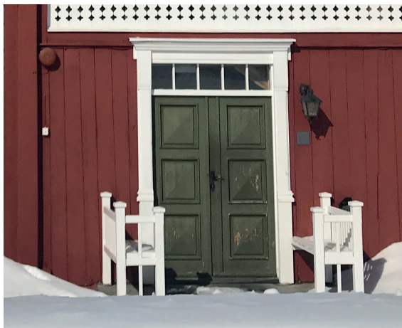
Dagens inngangsdør. Tofløyet med overlys. Malt.
