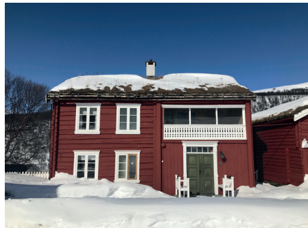
Østfasade med hovedinngang. Innglasset svalgang i 2. etg.
