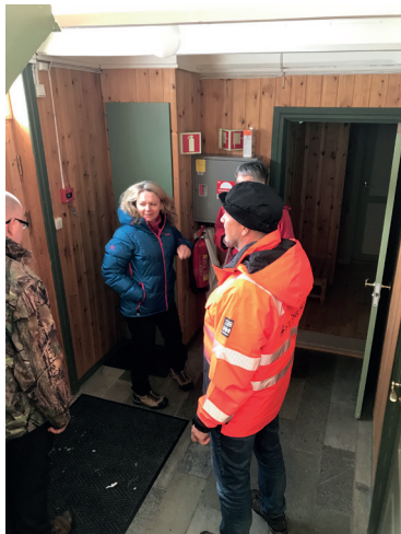
Foto av eksisterende situasjon, 1. etg.
