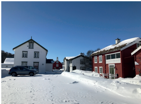
Nordre til høyre, Salongbygget/ Hovedbygget til venstre. Parkering.
