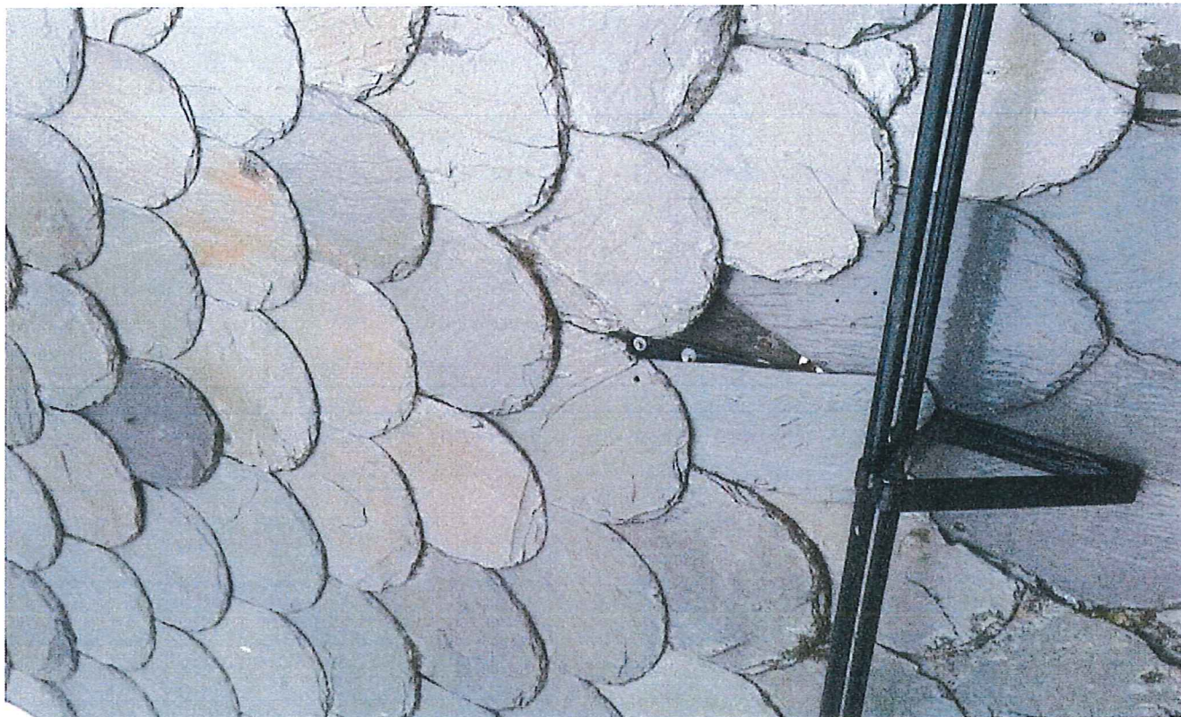
Ordre O2353. Filnavn: 20170606_092836.jpg. Beskrivelse: Tak over sakrestiet, stein mangler.
