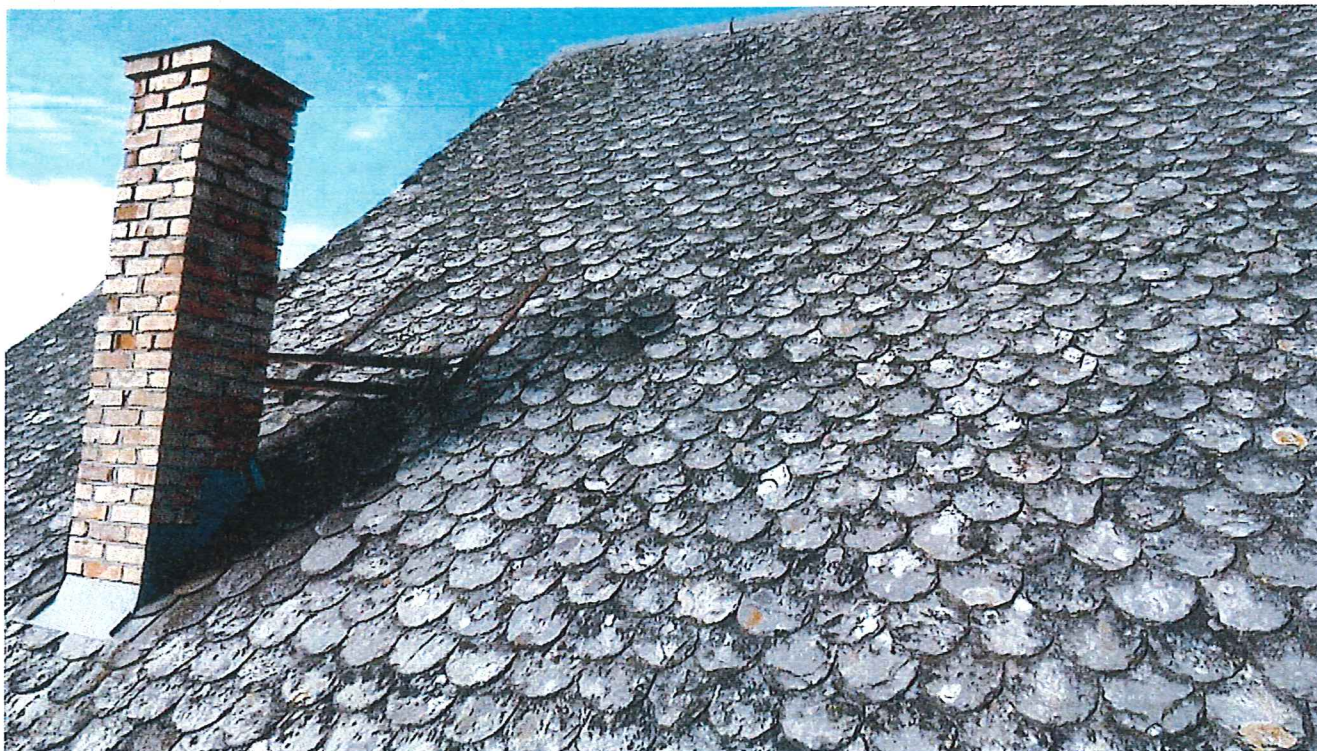
Ordre O2353. Filnavn: P_20170619_074314.jpg. Beskrivelse: pipe mot veien. ser bra ut
