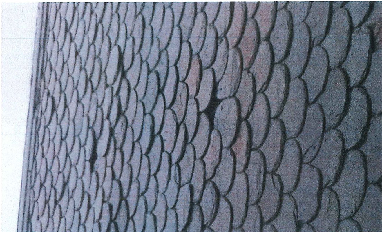
Ordre O2353. Filnavn: 20170606_080429.jpg. Beskrivelse: Stein mangler på hovedtak.
