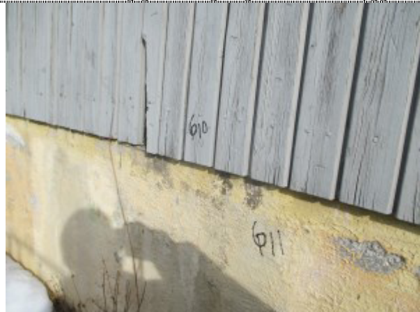
Bilde 3.14 Gul maling ringmur Gymsal 2
