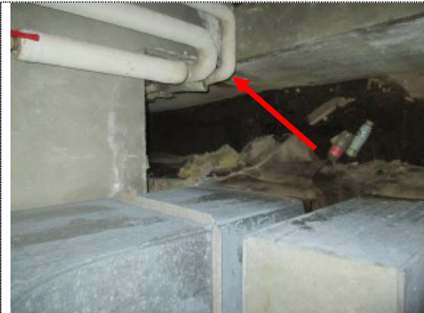
Bilde 3.3 Rørbend Personalbygg
