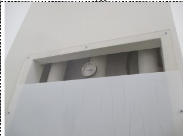
Bilde 3.5 Innkassede rør i veggen i Gymsal 2
