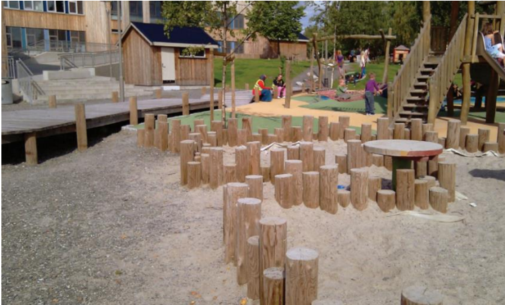
Eksempel på stående rundstokk som avgrensning av sandbasseng.
