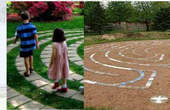
LABYRINT Labyrint lages i store heller som legges i grusen (bilde til venstre). Grus skal være samme som på grillplass, trillbar 0-16.
