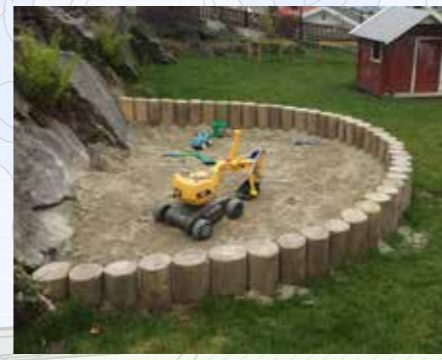
SANDKASSE Kant i stående rundstokk Kant skal være jevn, 30cm høy. Diameter rundstokk 20cm.
