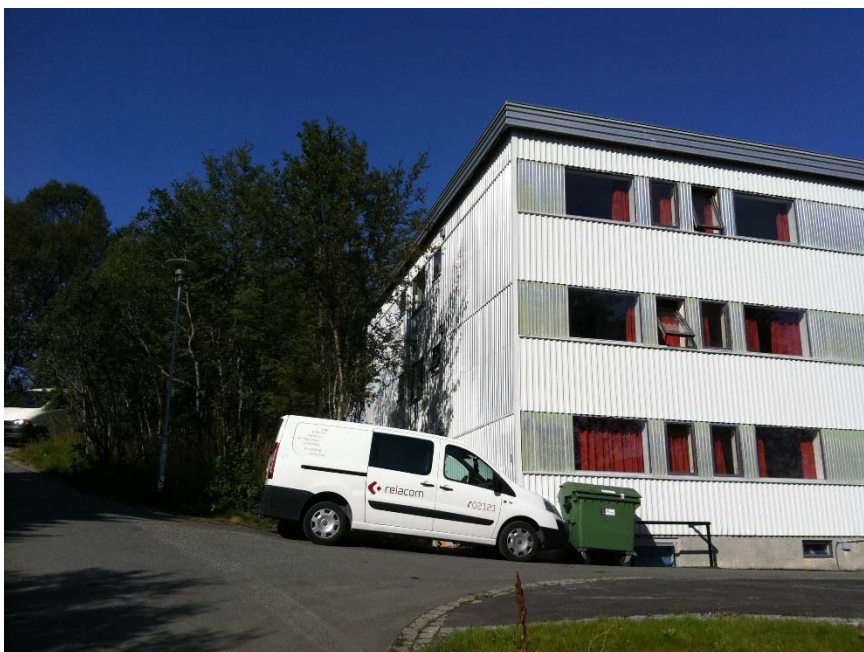
Bilde 12. Hybelbygg, fasade mot vest og syd.
