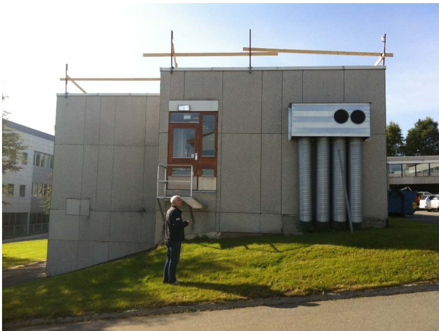
Bilde 8. Bygg L, fasade mot øst
