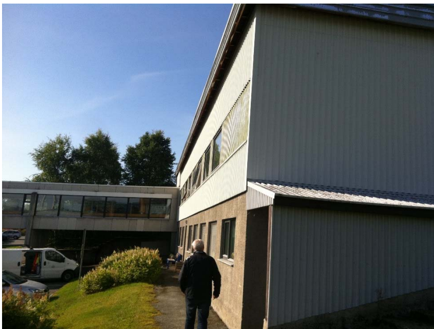
Bilde 6: Bygg M, fasade mot syd
