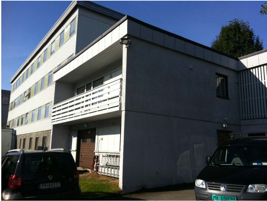
Bilde 1: Bygg H, fasade mot syd
