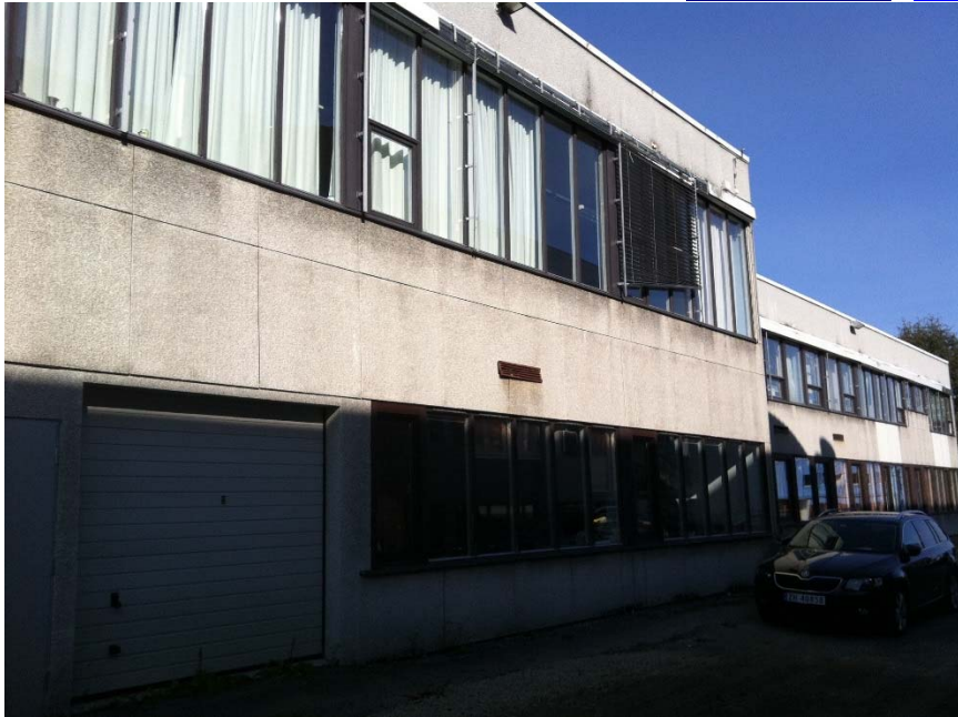
Bilde 9. Bygg L, fasade mot syd.
