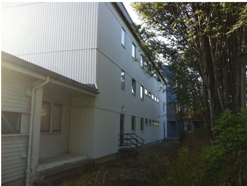
Bilde 2: Bygg H, fasade mot nord.
