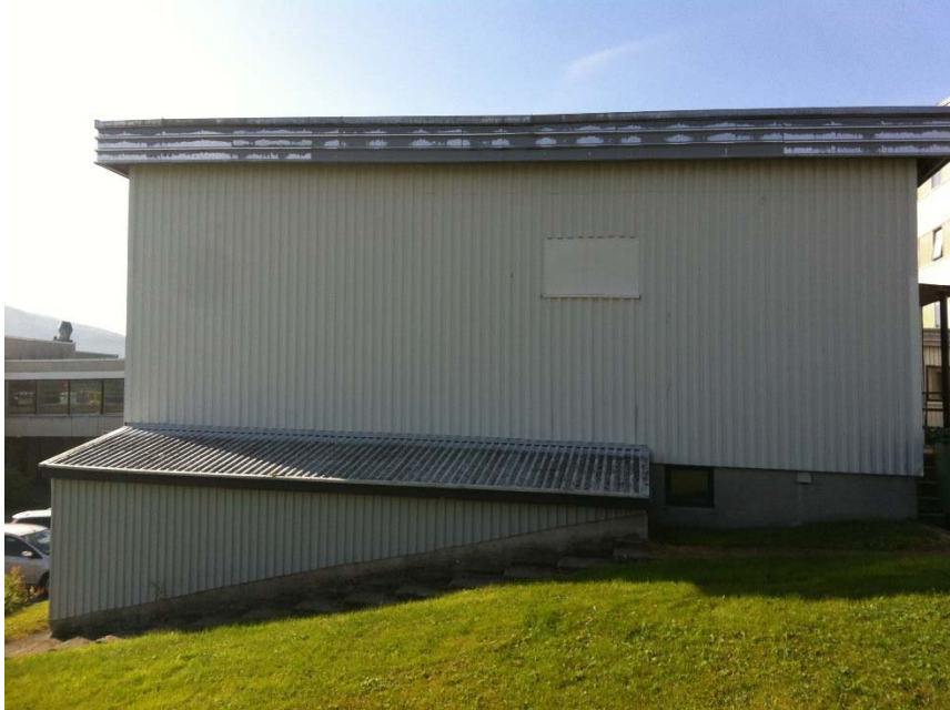
Bilde5: Bygg M, fasade mor øst
