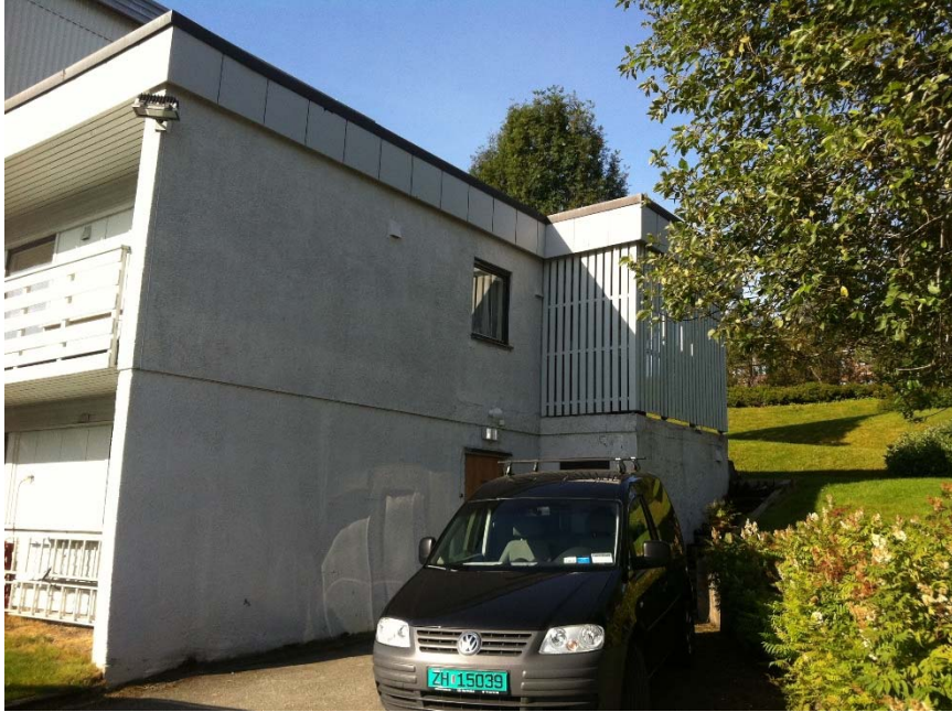
Bilde 3: Bygg H, fasade mot øst.
