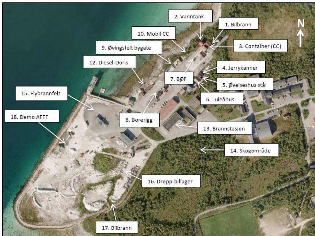
Figur 2. Flyfoto som viser de forskjellige lokalitetene på brannskolen som omtales i denne rapporten. Figuren er hentet fra rapport utarbeidet av Multiconsult /12/.
