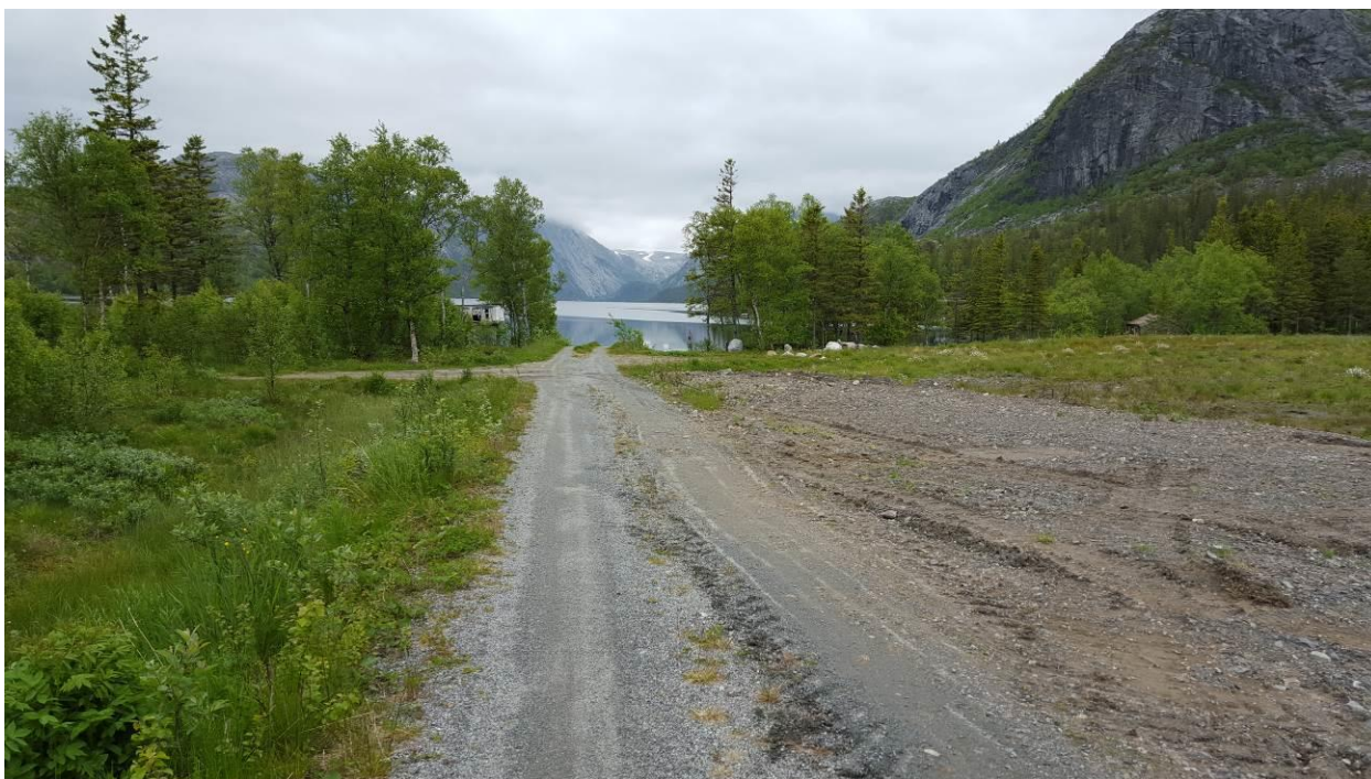
Bilde 2 Rigg- og lagerområde, med utsikt mot Vassenden
