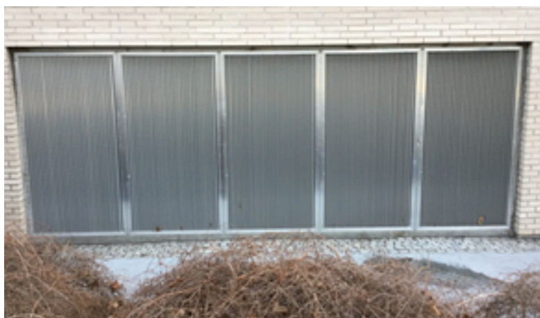
Bilde 3.6.0-1 og 3.6.0-2: Inntaksrist og avkastsrist.
