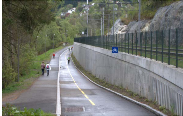
Figur 4: Legg merke til avstand mellom mur og sykkelvei. Ved Harevegen, Skjold. Foto: Geir Bartz-Johannessen
