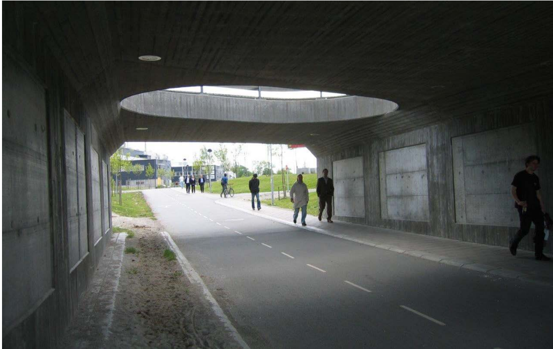
Figur 24: Bilde: Lys og åpen kulvert med separert tilbud i Lund
