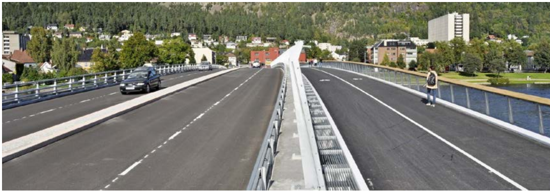
Figur 23: Bro Øvre Sund, Drammen. Foto: Statens vegvesen
