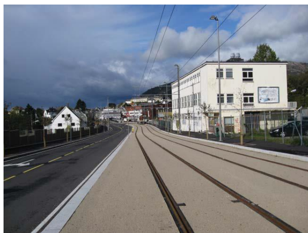
Figur 5. Inndalsveien med maisbelegg. Kilde: Prosjekterings og utbyggings veileder, s. 8
