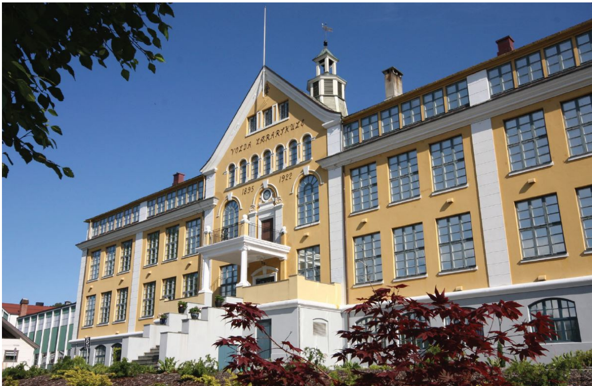
Figur 17 Kaarstad 1922, der ventilasjonsanlegg no skal leggjast inn.
